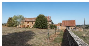
Vue de la demeure (façade postérieure) de la Mollière et de ses dépendances, depuis le jardin. Phot. Pierre-Marie Barbe-Richaud IVR26_20197100326NUC4AQ
