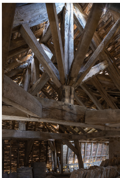
Détail de la charpente : poinçon et contrefiches Phot. Pierre-Marie Barbe-Richaud IVR26_20197100320NUC4A
