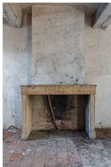
Cheminée d'une des anciennes chambres de la demeure Phot. Pierre-Marie Barbe-Richaud IVR26_20197100321NUC4A
