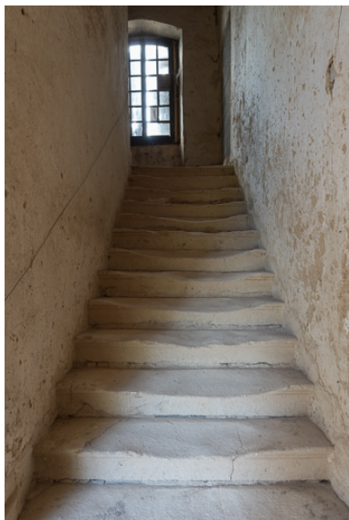
Une des volées de l'escalier rampe sur rampe de la demeure Phot. Pierre-Marie Barbe-Richaud IVR26_20197100313NUC4A
