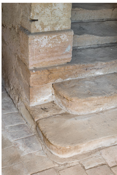
Moulure, à la base du mur-noyau de l'escalier Phot. Pierre-Marie Barbe-Richaud IVR26_20197100315NUC4A
