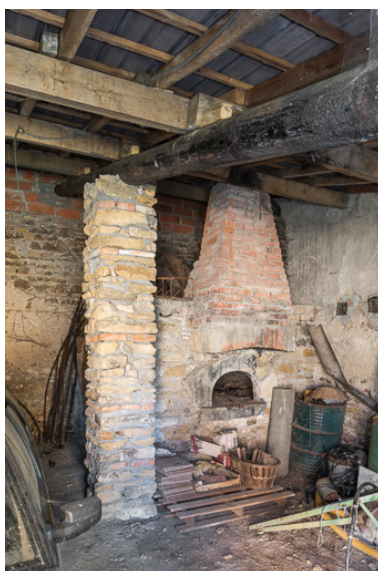
Four à pain du XIXe siècle, contre la façade nord-est de la demeure Phot. Pierre-Marie Barbe-Richaud IVR26_20197100333NUC4A
