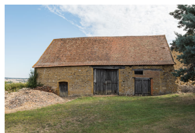
Façade antérieure de l'aile principale des dépendances, orientée à l'ouest Phot. Pierre-Marie Barbe-Richaud IVR26_20197100334NUC4A
