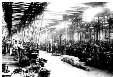
Atelier d'usinage. Photogr., s.n., s.d. [vers 1908]. Autr. IVR43_20122501485NUC2
