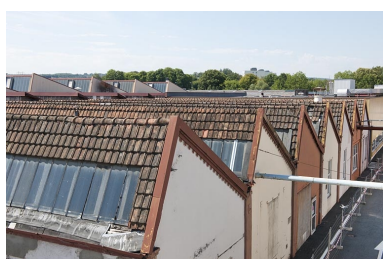
Pignons de l'atelier des boîtes de vitesses. Phot. Jérôme Mongreville IVR43_20112502115NUC4A
