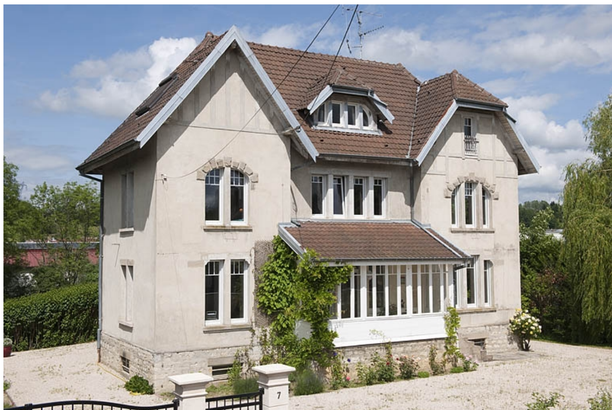
Logement (patronal ?) rue des Refroidières.
