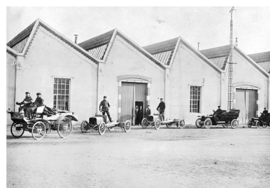
Manutention de châssis devant un atelier. Photogr., s.n., s.d. [vers 1908]. Autr. IVR43_20122501472NUC2
