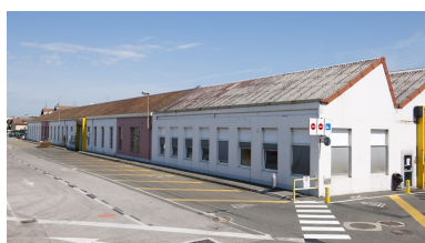
Façade sud de l'atelier des tours. Phot. Jérôme Mongreville IVR43_20112502123NUC4A
