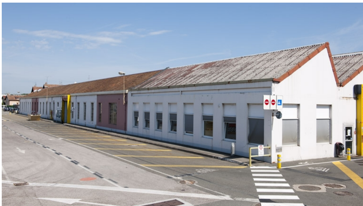
Façade sud de l'atelier des tours.
