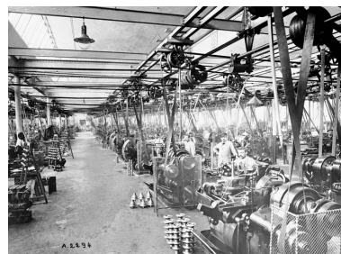
Usine d'Audincourt (?). Atelier de tournage de pièces. Photogr., s.n., s.d. [début 20e siècle]. Autr. IVR43_20122501475NUC2
