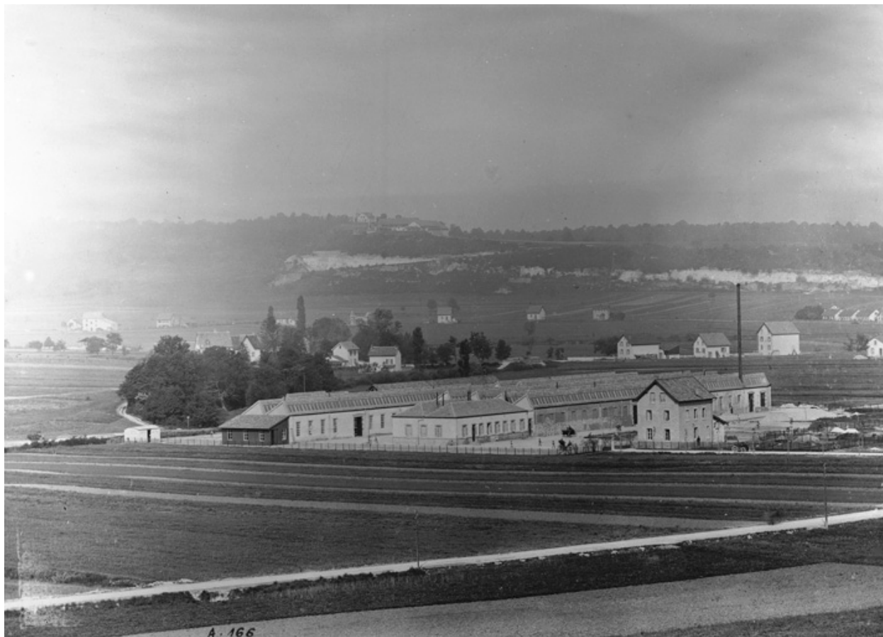
L'usine en construction. Photogr., s.n., s.d. [vers 1898].
