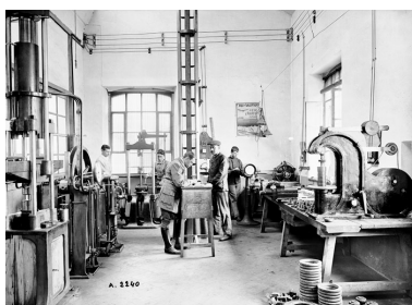
Laboratoire d'essais. Photogr., s.n., s.d. [vers 1912]. Autr. IVR43_20122501489NUC2
