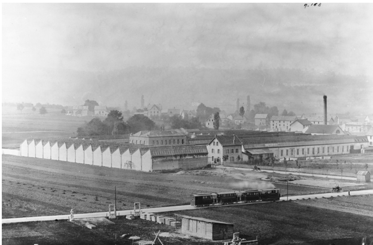
Vue d'ensemble depuis le nord-est. Photogr., s.n., s.d. [début du 20e siècle].
