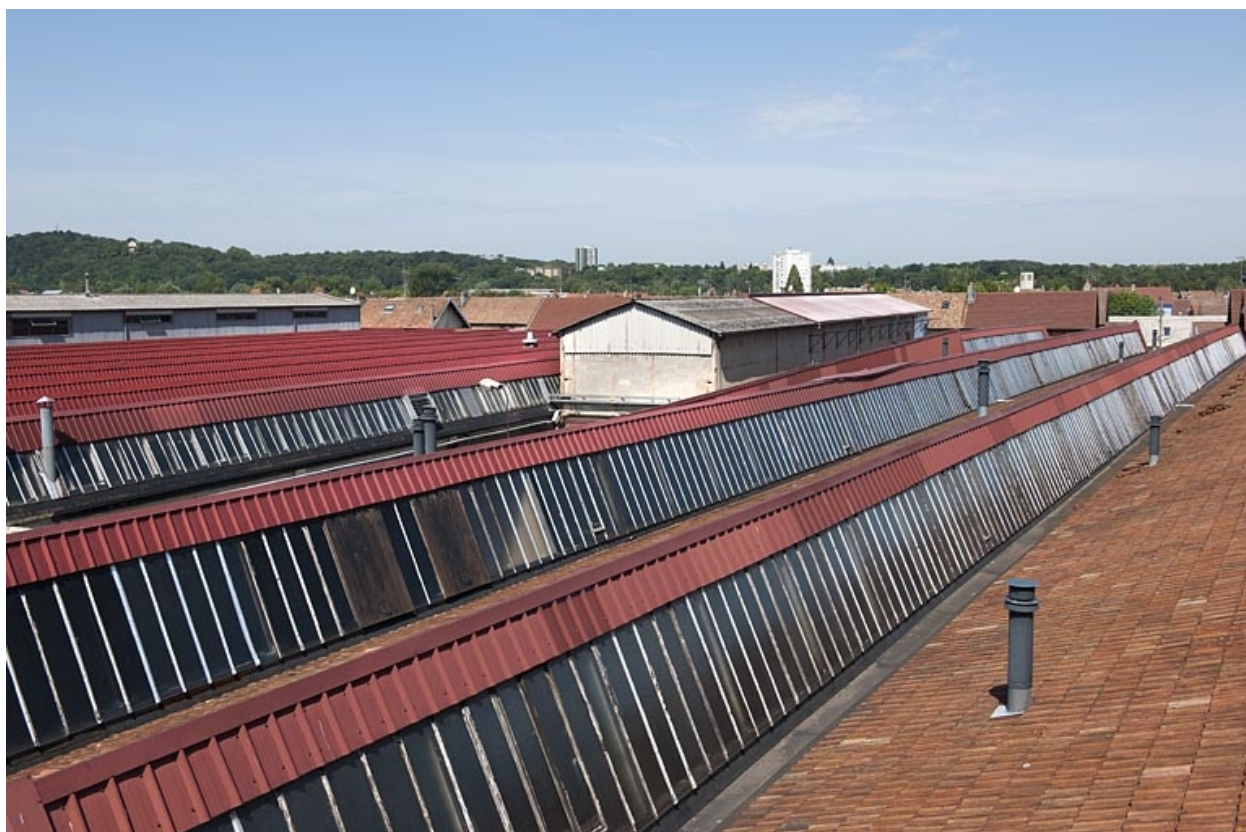
Sheds de l'atelier de montage des voitures.
