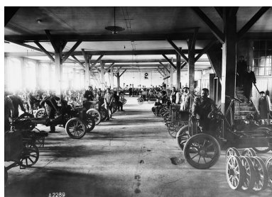
Usine d'Audincourt (?). Atelier de montage. Photogr., s.n., s.d. [début 20e siècle]. Autr. IVR43_20122501479NUC2
