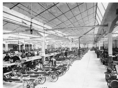
Usine d'Audincourt (?). Atelier de montage des châssis. Photogr., s.n., s.d. [début 20e siècle]. Autr. IVR43_20122501478NUC2
