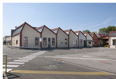
Sellerie, puis menuiserie et magasin. Phot. Jérôme Mongreville IVR43_20112502101NUC4A
