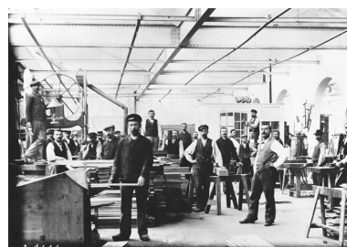
Atelier de menuiserie (carrossage ?). Photogr., s.n., s.d. [vers 1900]. Autr. IVR43_20122501484NUC2
