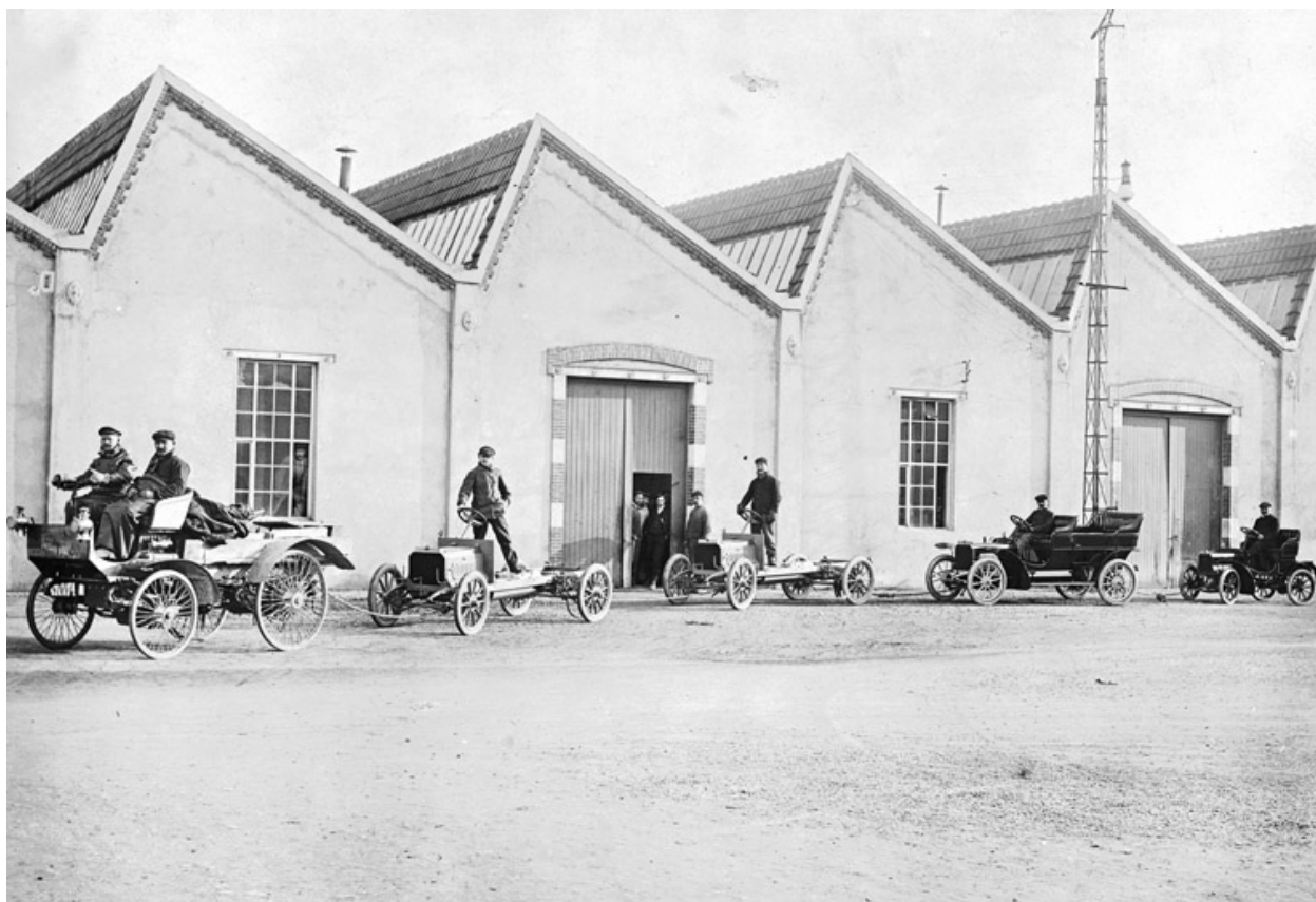
Manutention de châssis devant un atelier. Photogr., s.n., s.d. [vers 1908].
