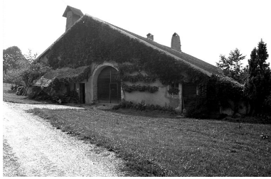
Façade antérieure. Phot. Liliane Hamelin IVR43_19762500860Z
