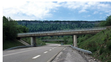
Vue d'ensemble, depuis le nord. Phot. Yves Sancey IVR43_20053900077ZA
