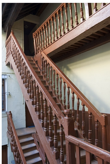
Escalier à cage ouverte à droite dans la première cour : détail des volées supérieures. Phot. Jérôme Mongreville IVR43_20112500158NUC4A
