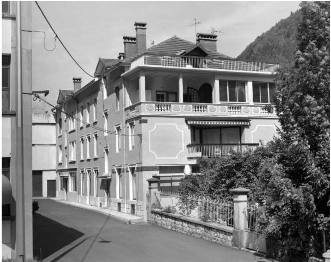
Logements et bureau.
