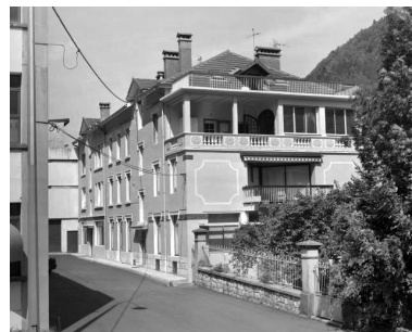
Logements et bureau.
