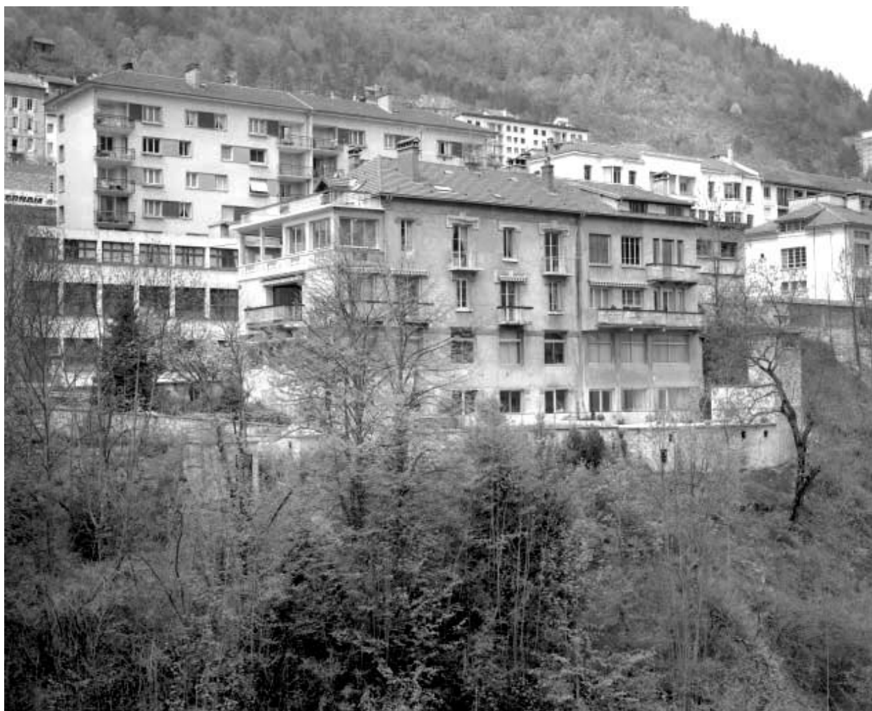
Logements et bureau depuis le sud.
