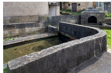
Muret protégeant les laveuses. Phot. Jérôme Mongreville IVR43_20177000477NUC4A
