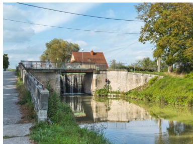
Vue d'ensemble du pont.
