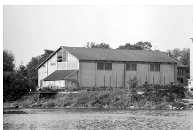
Centrale hydroélectrique, depuis l'est. Phot. Laurent Poupard IVR43_19883900596Z
