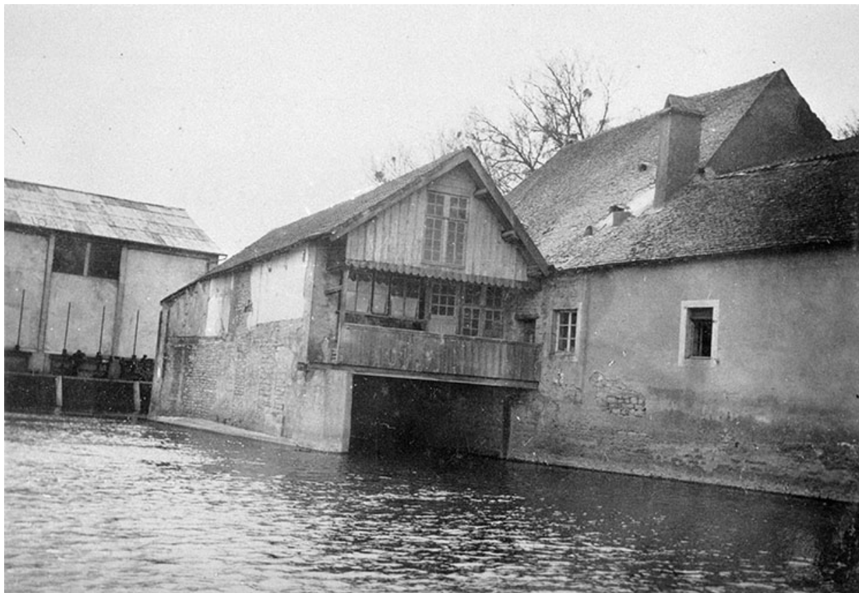
Moulin. Côté canal d'amenée.
