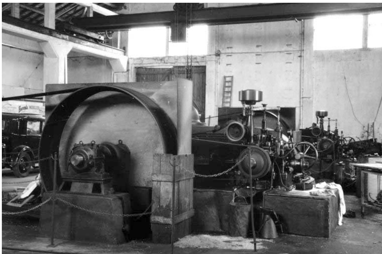
Centrale hydroélectrique, intérieur : transmission de la turbine.
