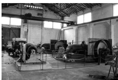
Centrale hydroélectrique, intérieur : transmission de la turbine et alternateur. Phot. Laurent Poupard IVR43_19883900597Z
