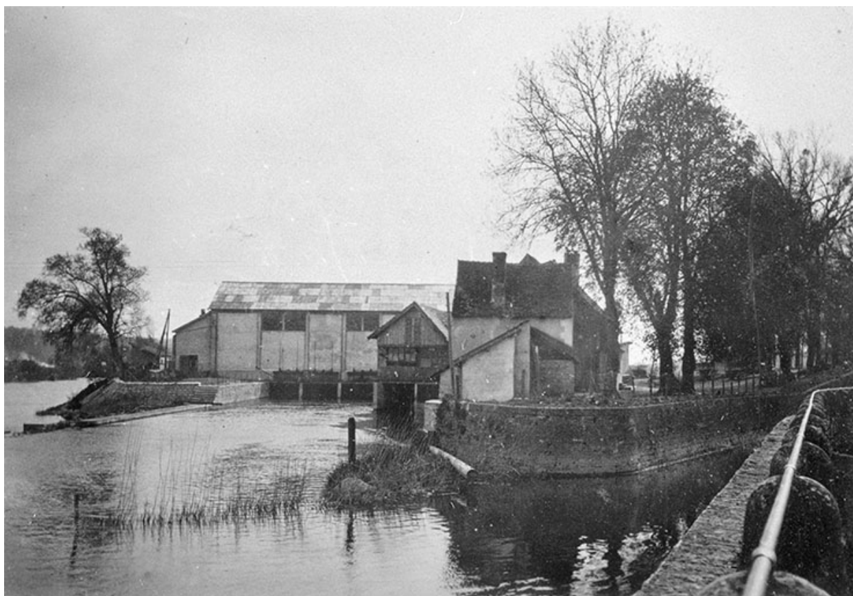
Station et moulin. Côté canal d'amenée.
