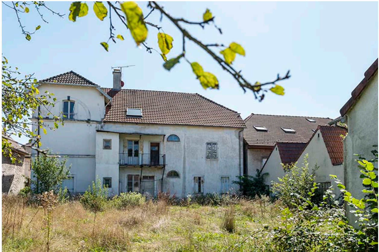
Logement : façade postérieure.
