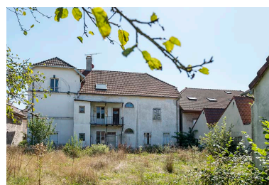
Logement : façade postérieure. Phot. Sonia Dourlot IVR43_20192501330NUC4A
