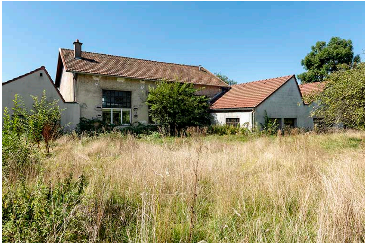
Usine : façade postérieure des ateliers (depuis l'est).
