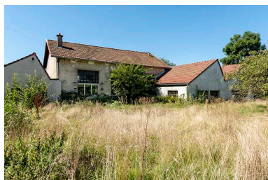
Usine : façade postérieure des ateliers (depuis l'est). Phot. Sonia Dourlot IVR43_20192501327NUC4A
