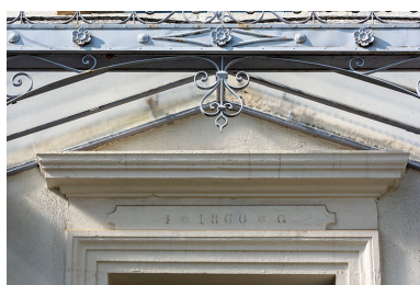
Logement : linteau daté. Phot. Sonia Dourlot IVR43_20192501332NUC4A
