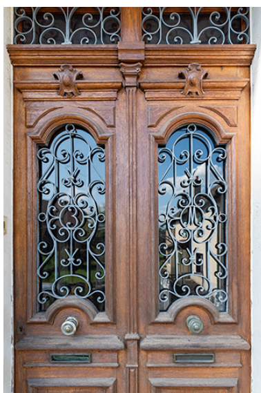
Logement : détail de la porte d'entrée. Phot. Sonia Dourlot IVR43_20192501333NUC4A
