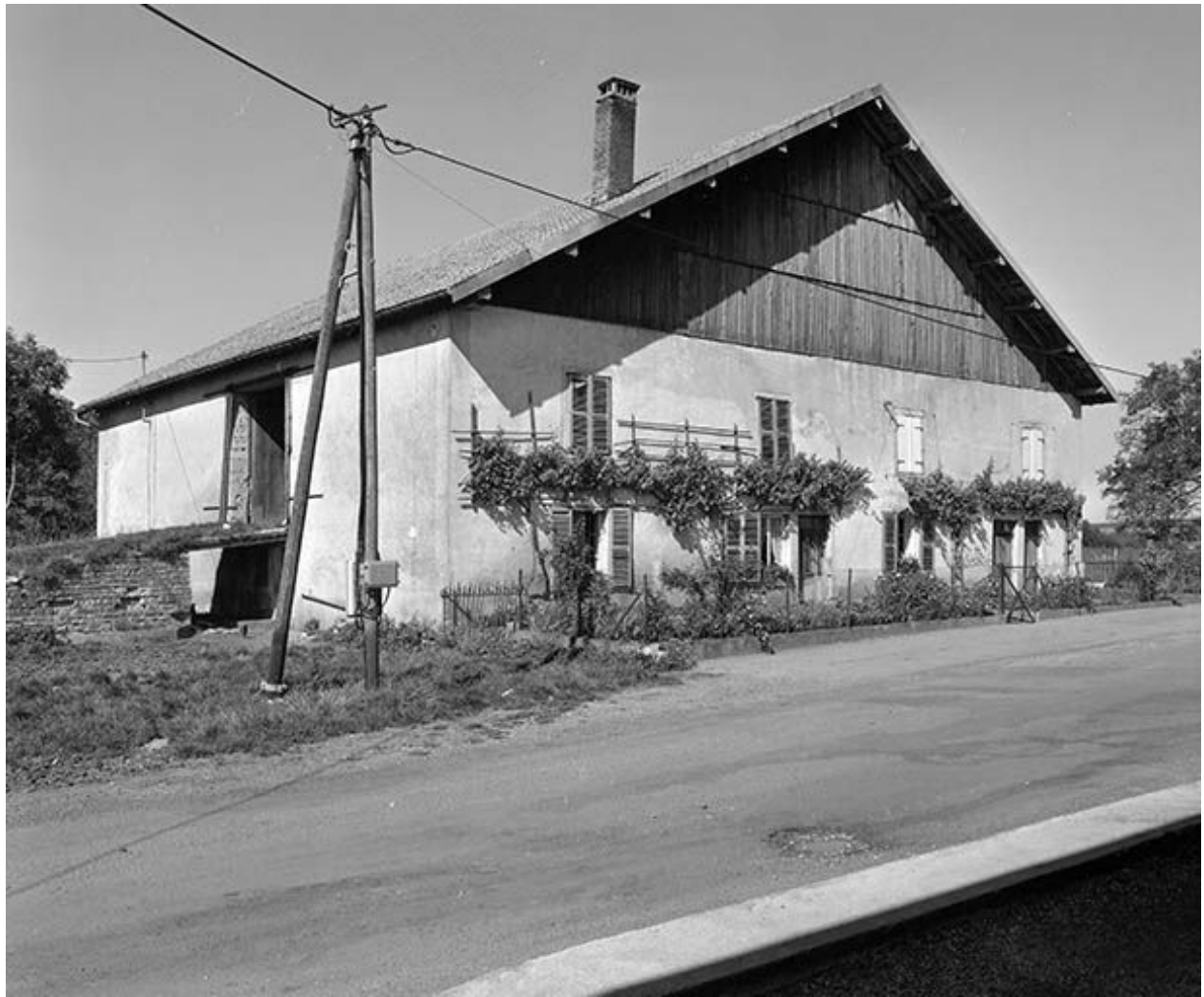
Ferme située chemin du Sel.
