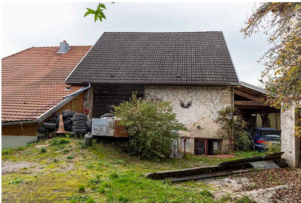
Façade latérale droite : la grange.
