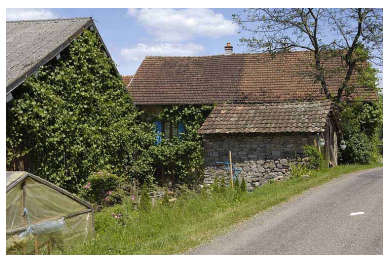
Façade postérieure du logement. Phot. Jérôme Mongreville IVR43_20057000347NUCA
