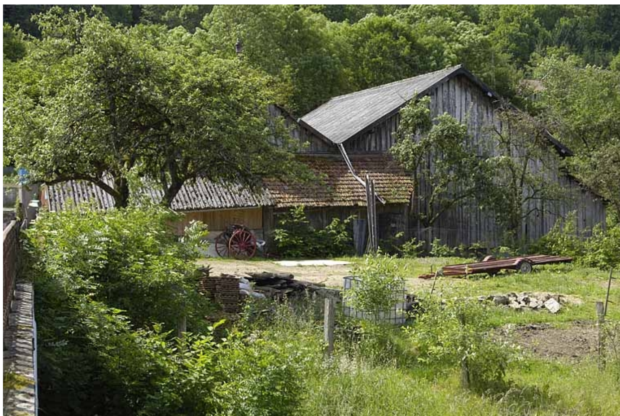
Pignons de l'atelier de scierie.
