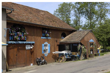
Façade est de l'atelier de scierie. Phot. Jérôme Mongreville IVR43_20057000350NUCA
