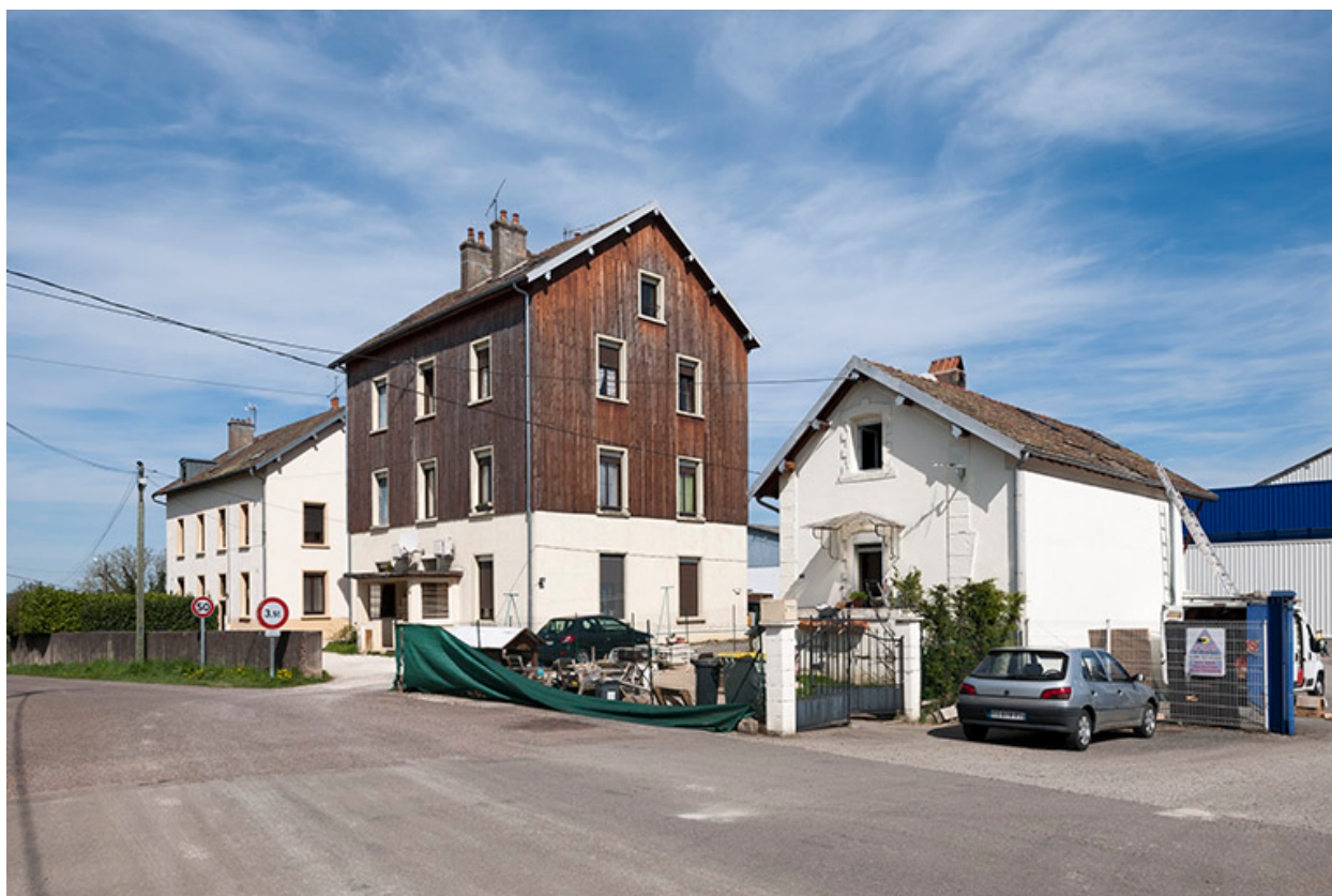
Logements, bureaux et conciergerie depuis la route.
