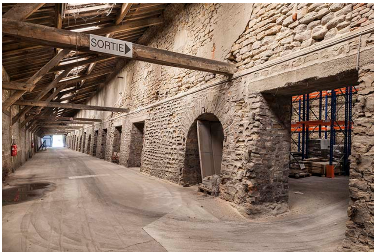
Ancien quai de chargement.
