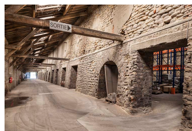
Ancien quai de chargement. Phot. Jérôme Mongreville IVR43_20152501052NUC4A
