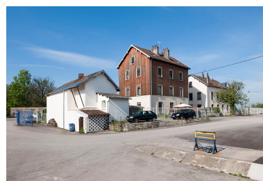
Conciergerie, bureaux et logements depuis la cour. Phot. Jérôme Mongreville IVR43_20152501055NUC4A
