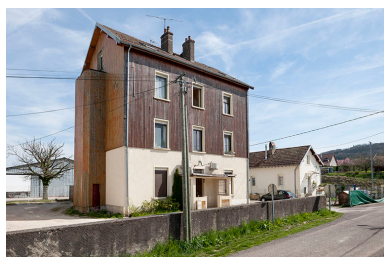
Ancien bâtiment de bureaux et logements. Phot. Jérôme Mongreville IVR43_20152501049NUC4A
