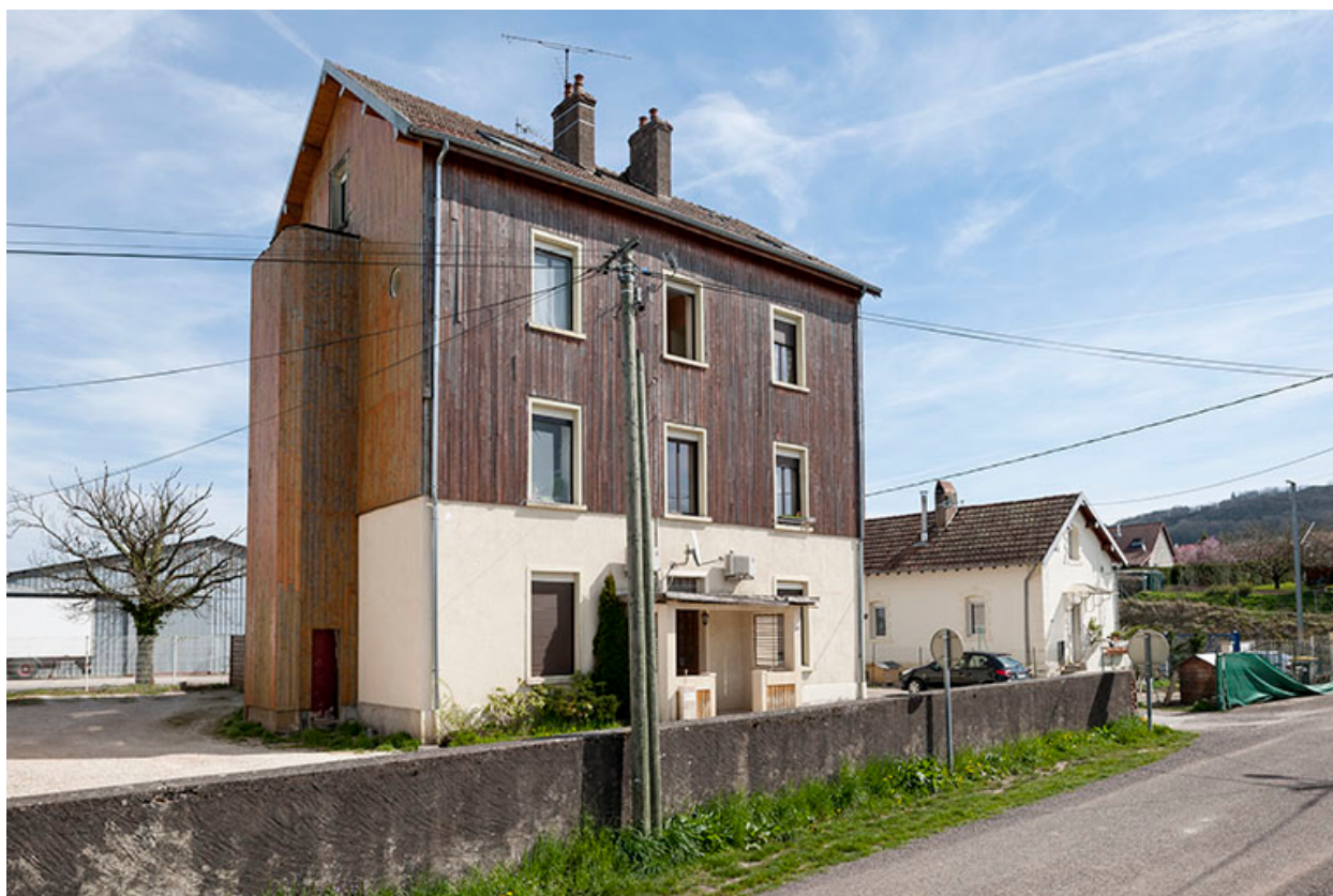
Ancien bâtiment de bureaux et logements.
