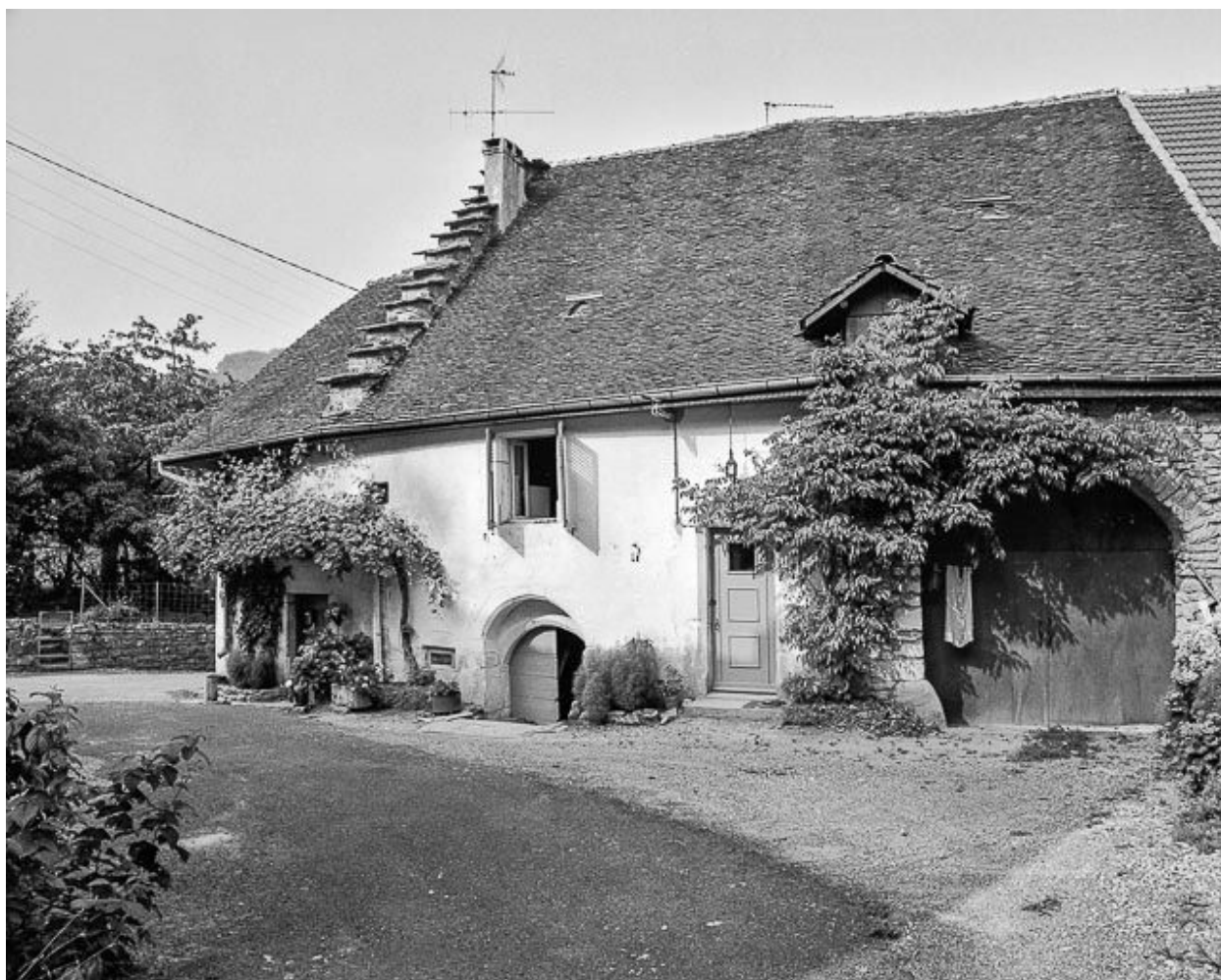
Maison de vigneron située rue des Rippes.
