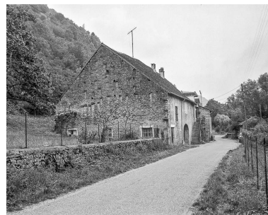
Ferme de vigneron située rue de l'Huilerie à Vaux-sous-Bornay. Phot. Yves Sancey IVR43_19843900253X
