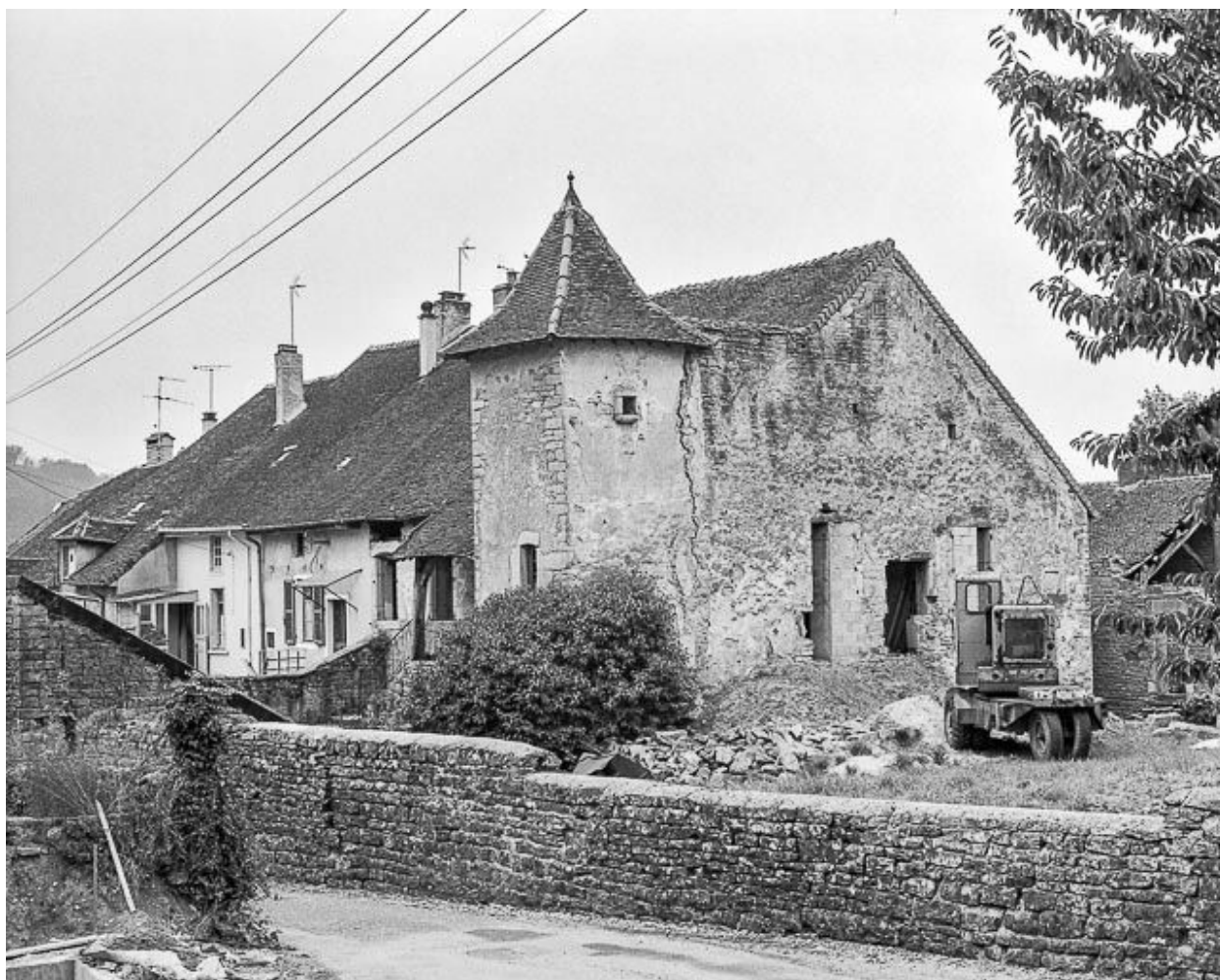
Maison de vigneron située place Jean Moulin.
