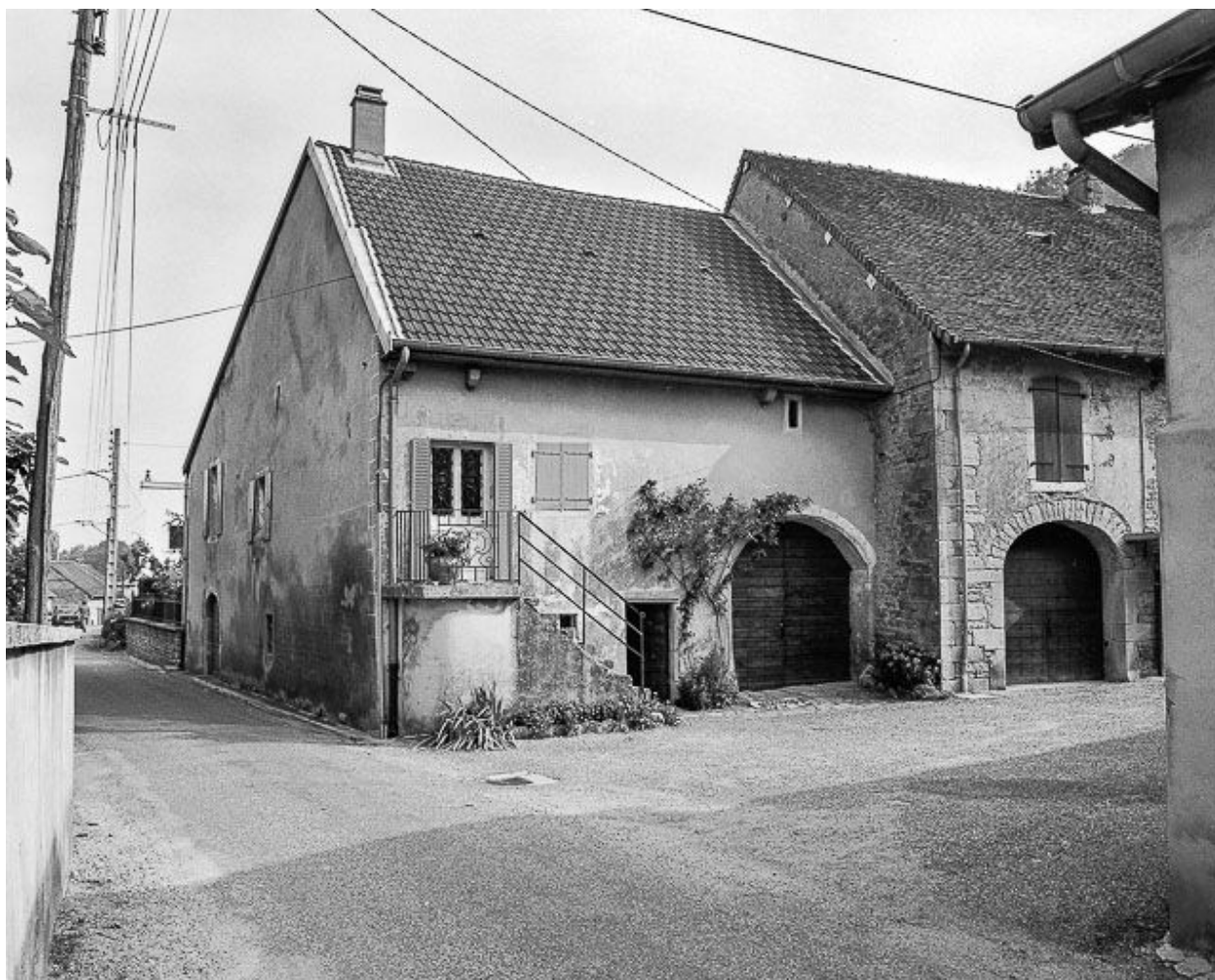
Maison de maréchal-ferrant située rue de l'Huilerie à Vaux-sous-Bornay.
