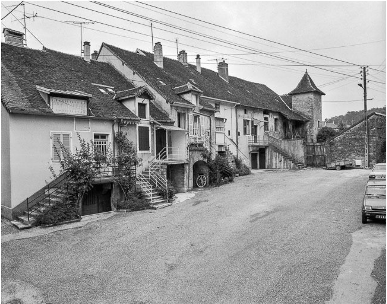
Maisons situées rue des Micholettes : façades antérieures.
