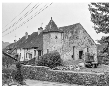
Maison de vigneron située place Jean Moulin. Phot. Yves Sancey IVR43_19843900238X
