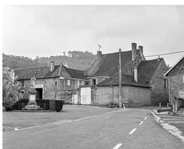
Maison de vigneron située place Jean Moulin. Phot. Yves Sancey IVR43_19843900244X
