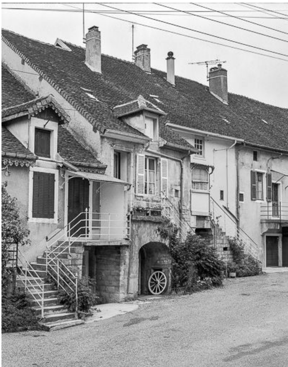
Maison de vigneron située rue des Micholettes.
