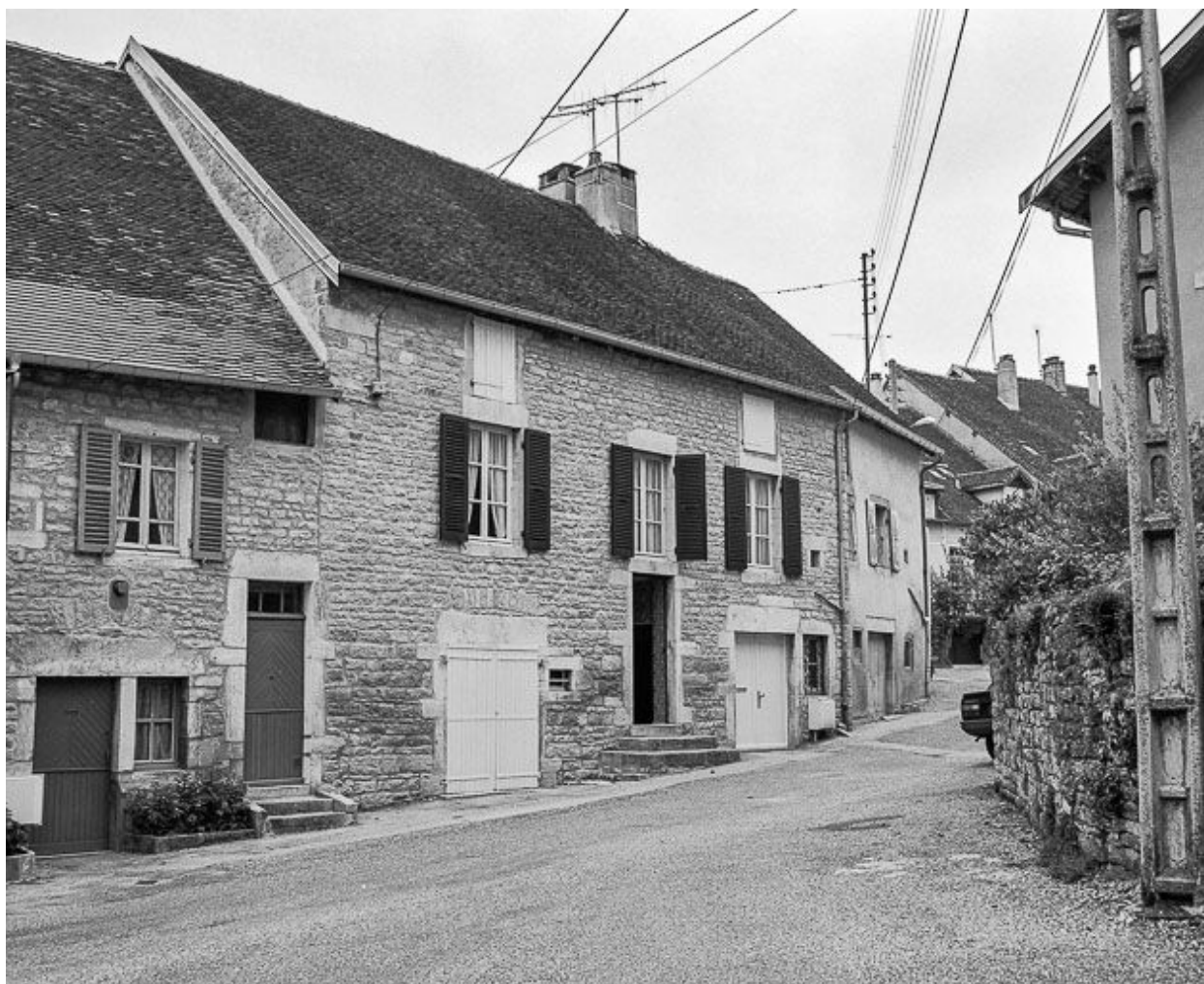
Maison de vigneron située rue des Micholettes.
