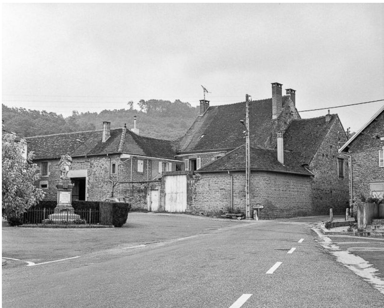
Maison de vigneron située place Jean Moulin.
