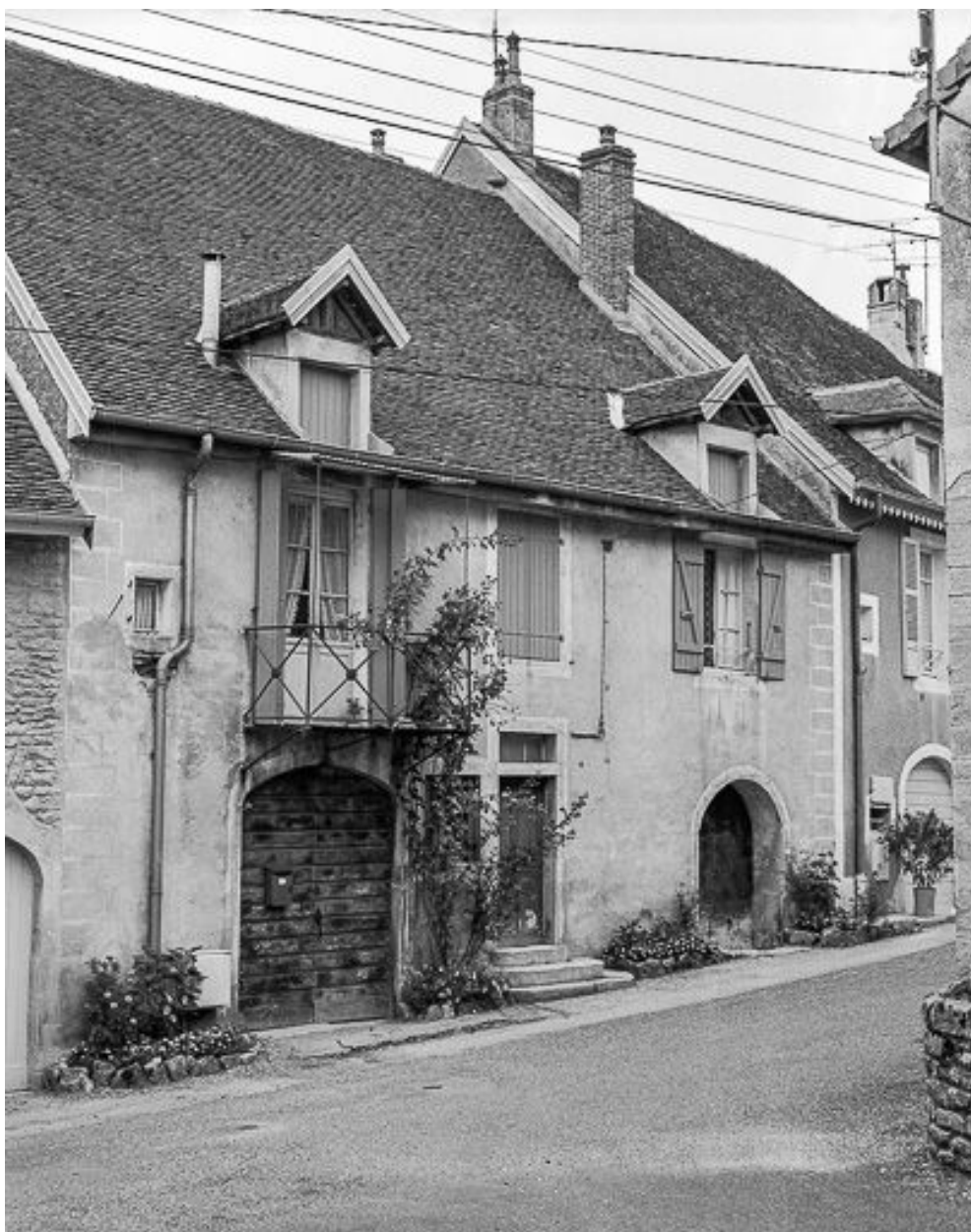
Maison de vigneron située rue des Micholettes.
