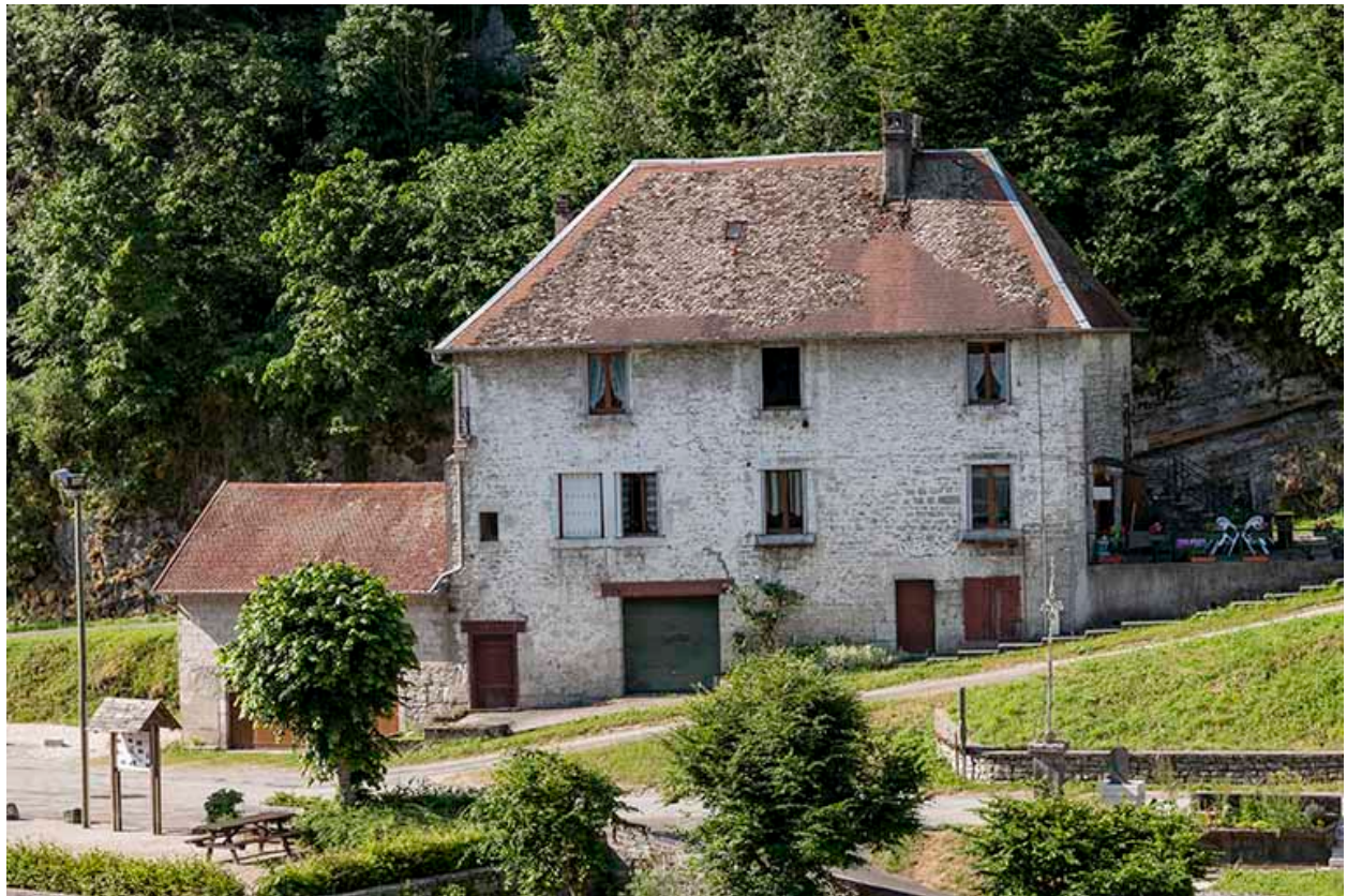
Logements d'ouvriers (route de Longeville).
