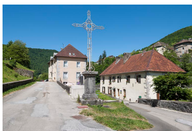
Logements d'ouvriers vus depuis l'est. Phot. Jérôme Mongreville IVR43_20152501493NUC4A
