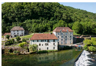
Logements d'ouvriers, depuis le nord. Phot. Jérôme Mongreville IVR43_20152501510NUC4A
