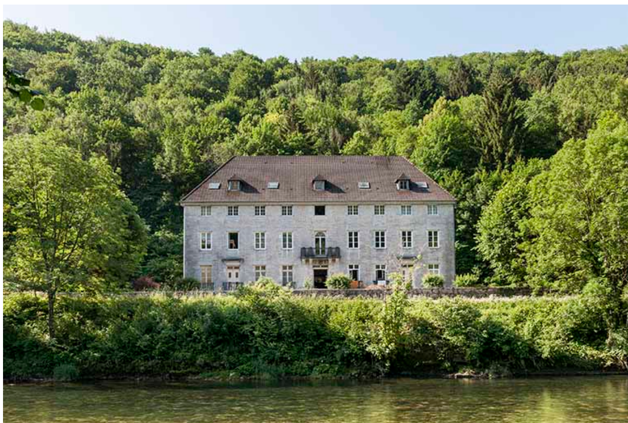
Façade antérieure du logement patronal.
