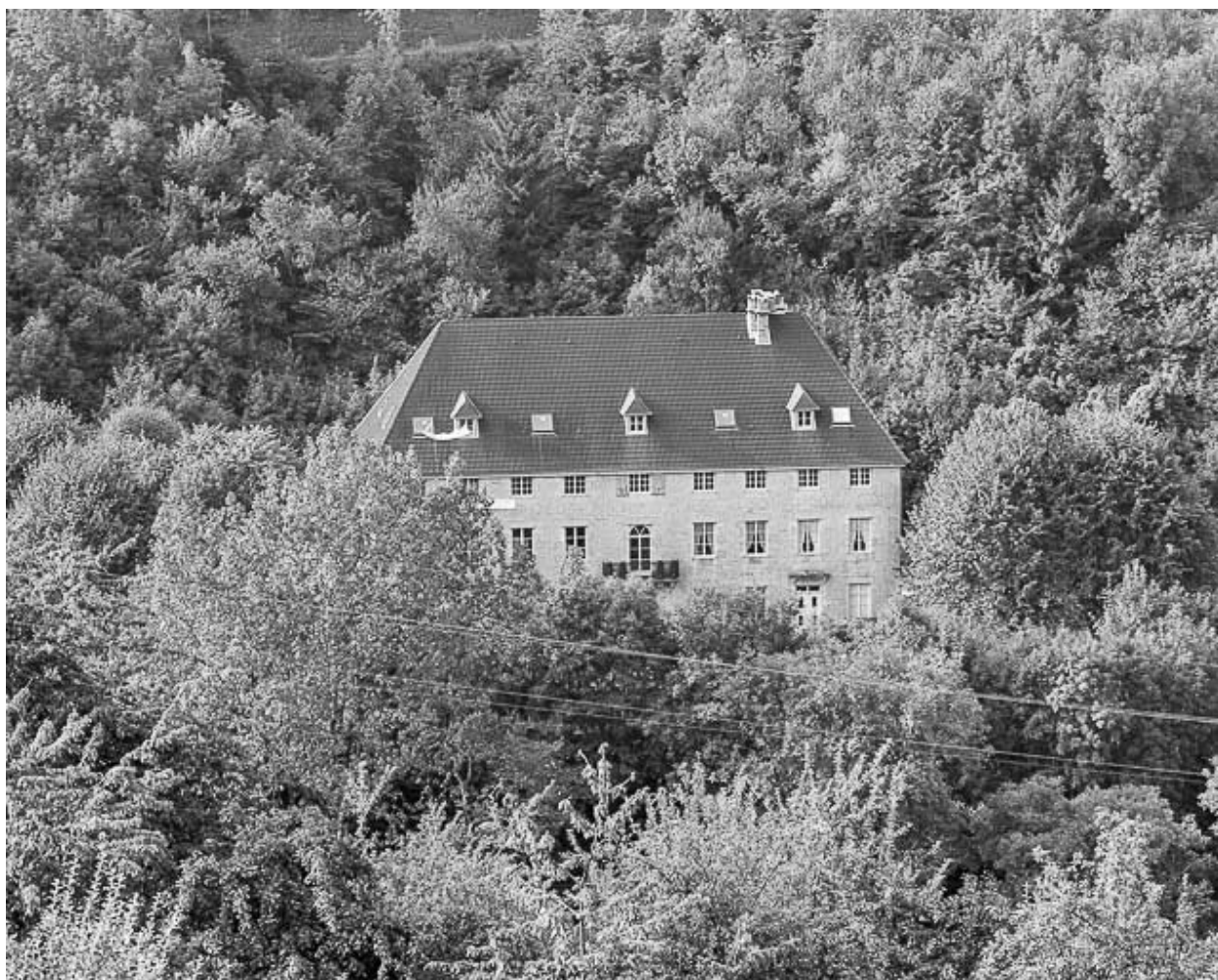
Vue plongeante sur le logement patronal en 1980.
