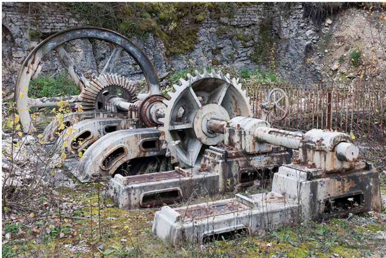
Turbine double. Vue de côté.
