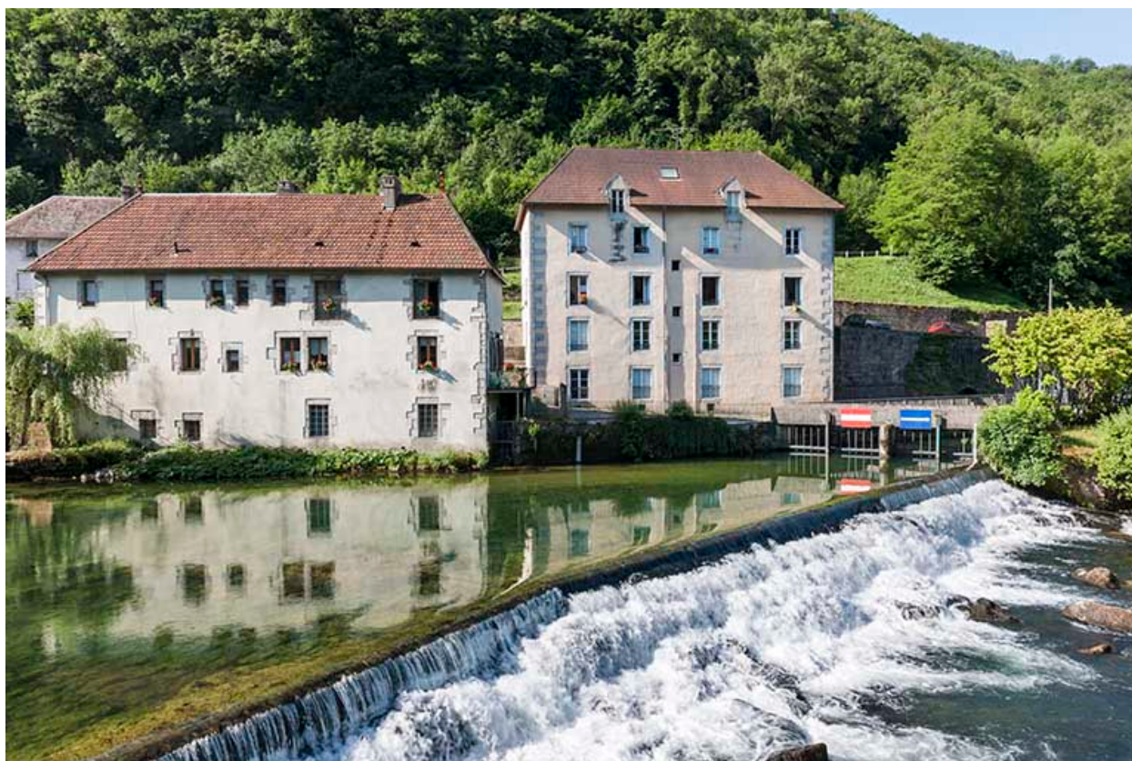
Façad nord des logements d'ouvriers.
