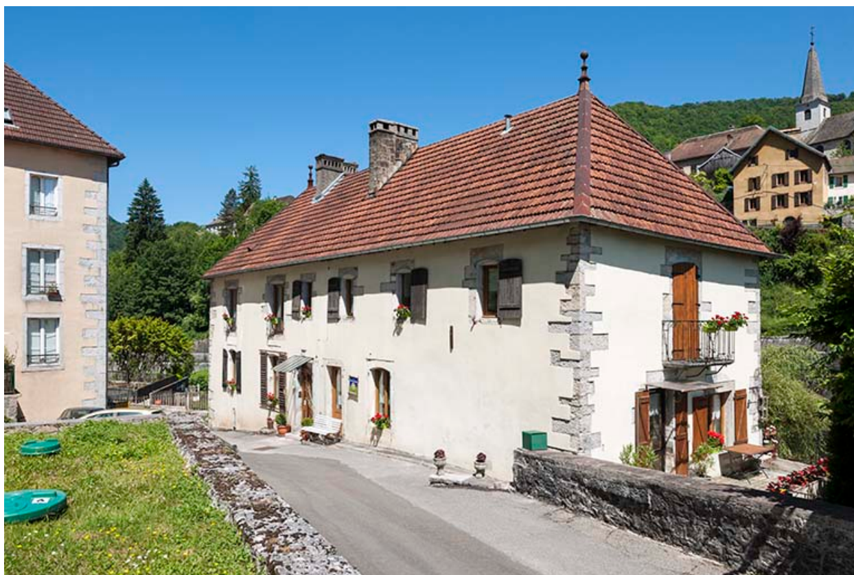
Logement d'ouvriers vue de trois quarts.
