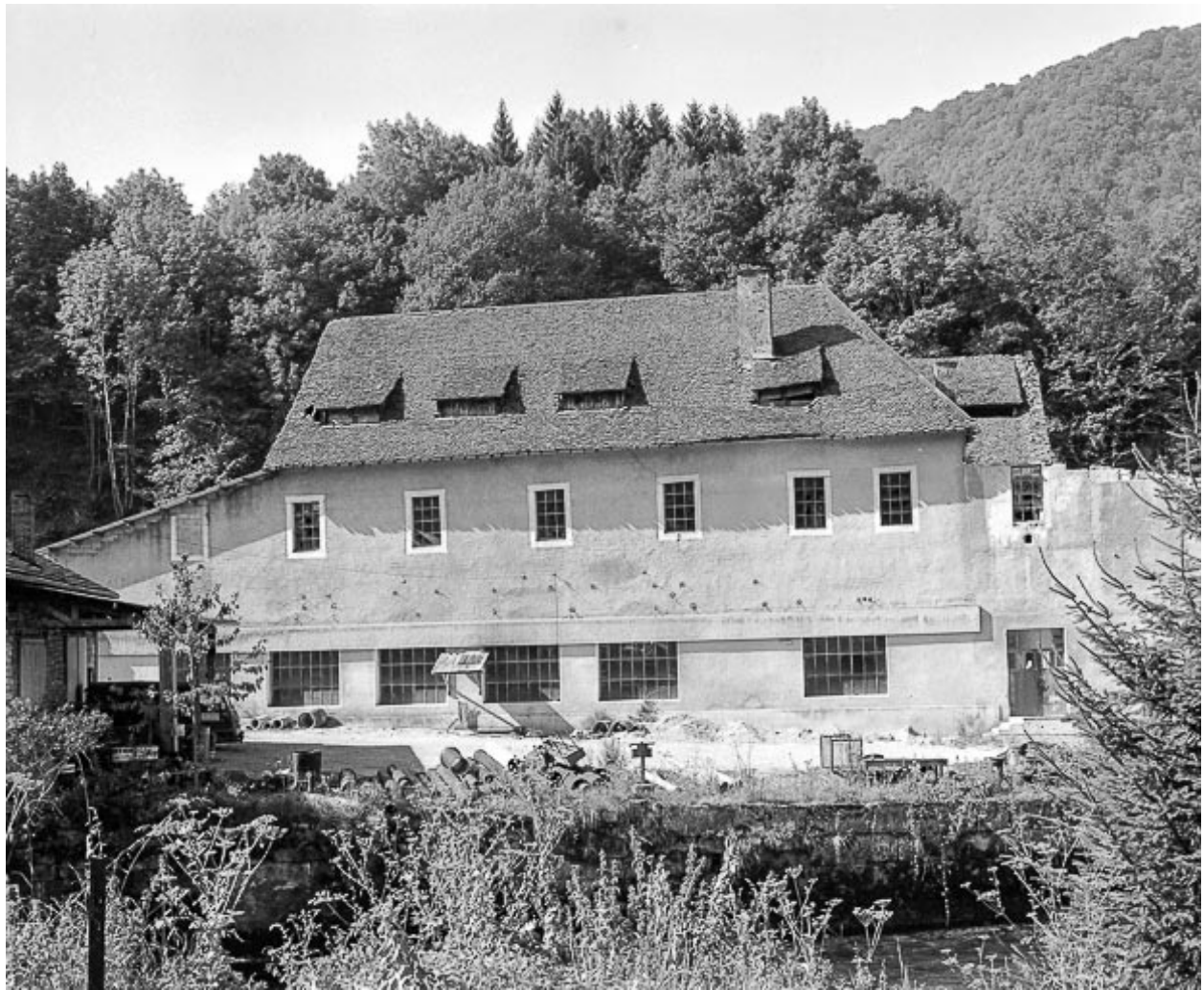
Façade nord de l'atelier dit "du laminoir" en 1980.
