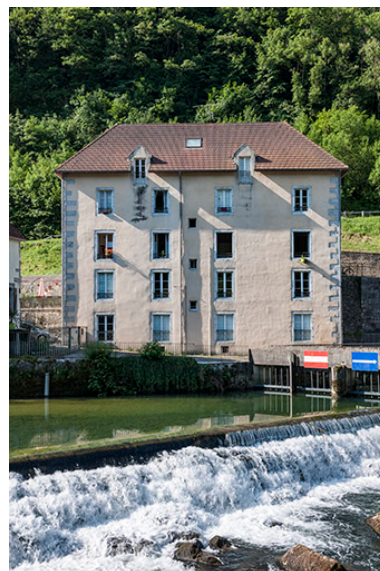
Façade nord d'un logement d'ouvriers. Phot. Jérôme Mongreville IVR43_20152501506NUC4A
