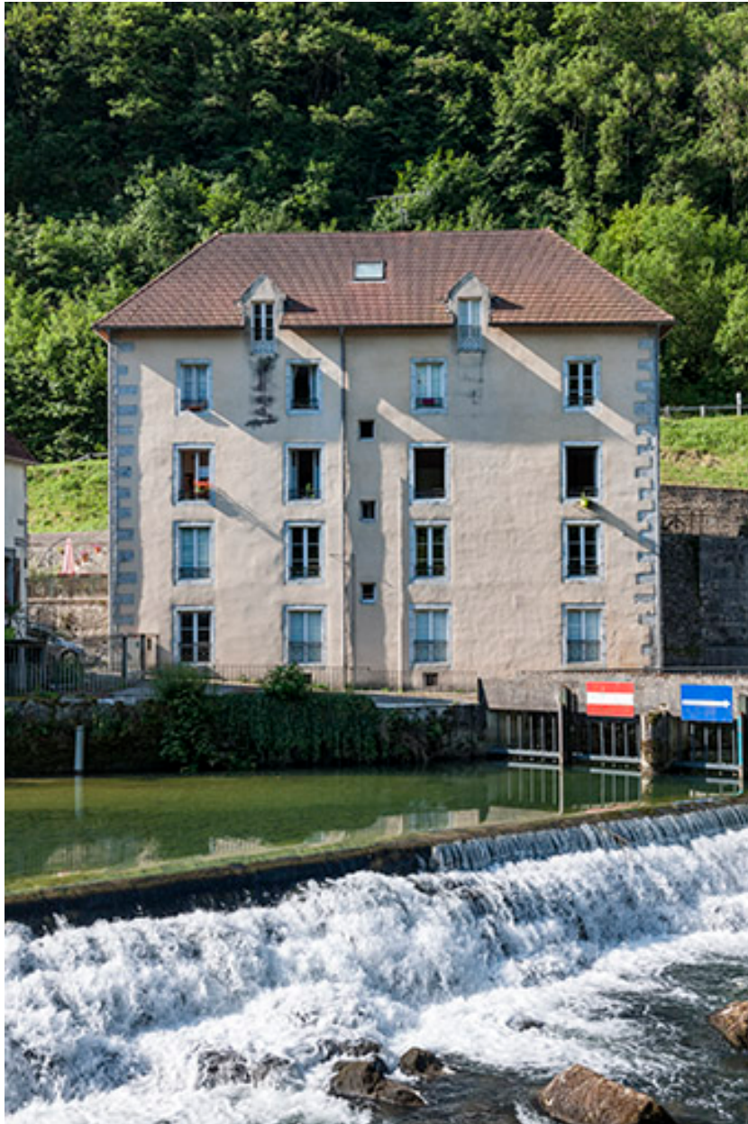
Façade nord d'un logement d'ouvriers.
