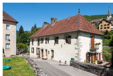
Logement d'ouvriers vue de trois quarts. Phot. Jérôme Mongreville IVR43_20152501494NUC4A
