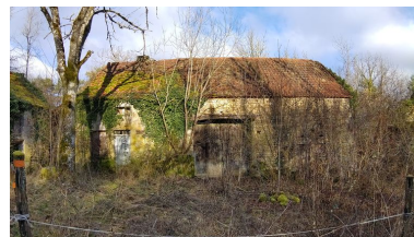
Vue de la maison ferme transversale ajoutée dans la seconde moitié du 19e siècle. Phot. Baptiste Quost IVR26_20242100089NUCA
