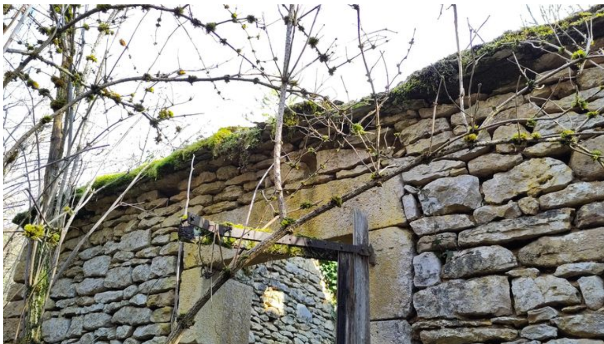
Détail de l'arase du mur gouttereau.
