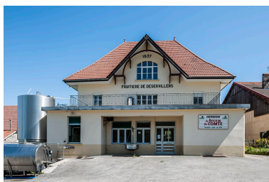
Vue de face. Phot. Jérôme Mongreville IVR43_20152500998NUC4A
