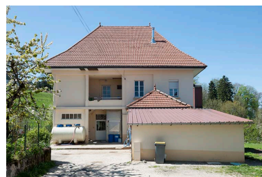
Façade postérieure. Phot. Jérôme Mongreville IVR43_20152500996NUC4A
