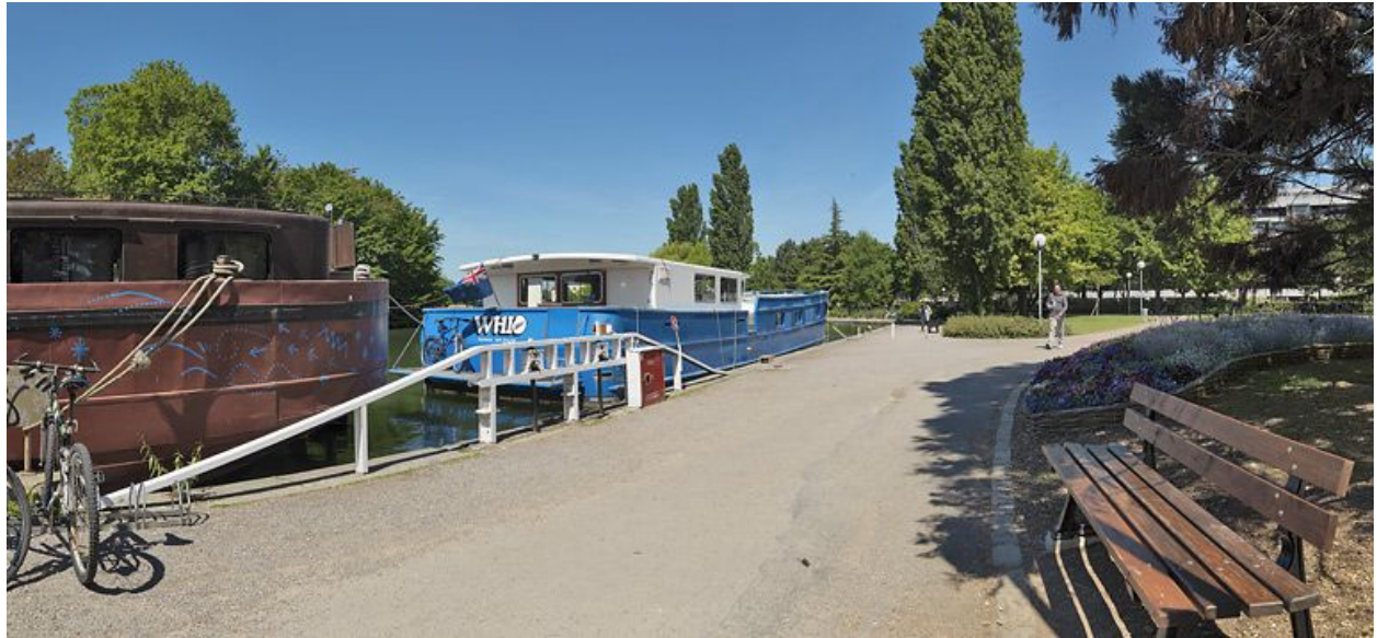
Vannes du déversoir de fond du port.
