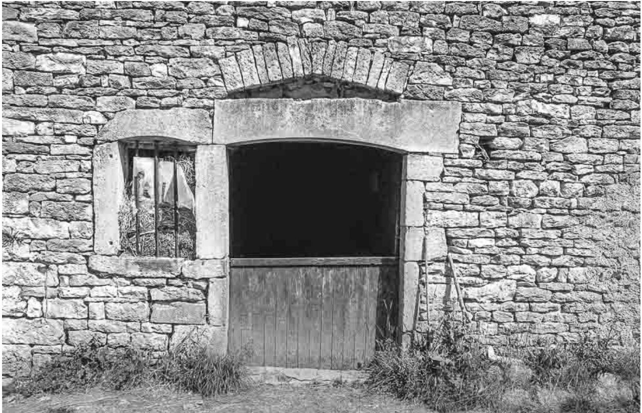
Détail : porte d'écurie sur façade latérale gauche.
