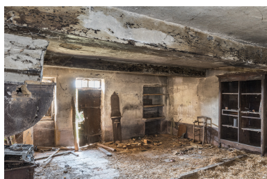
Vue intérieure de la pièce unique en rez-de-chaussée. Phot. Pierre-Marie Barbe-Richaud IVR26_20187100396NUC4A
