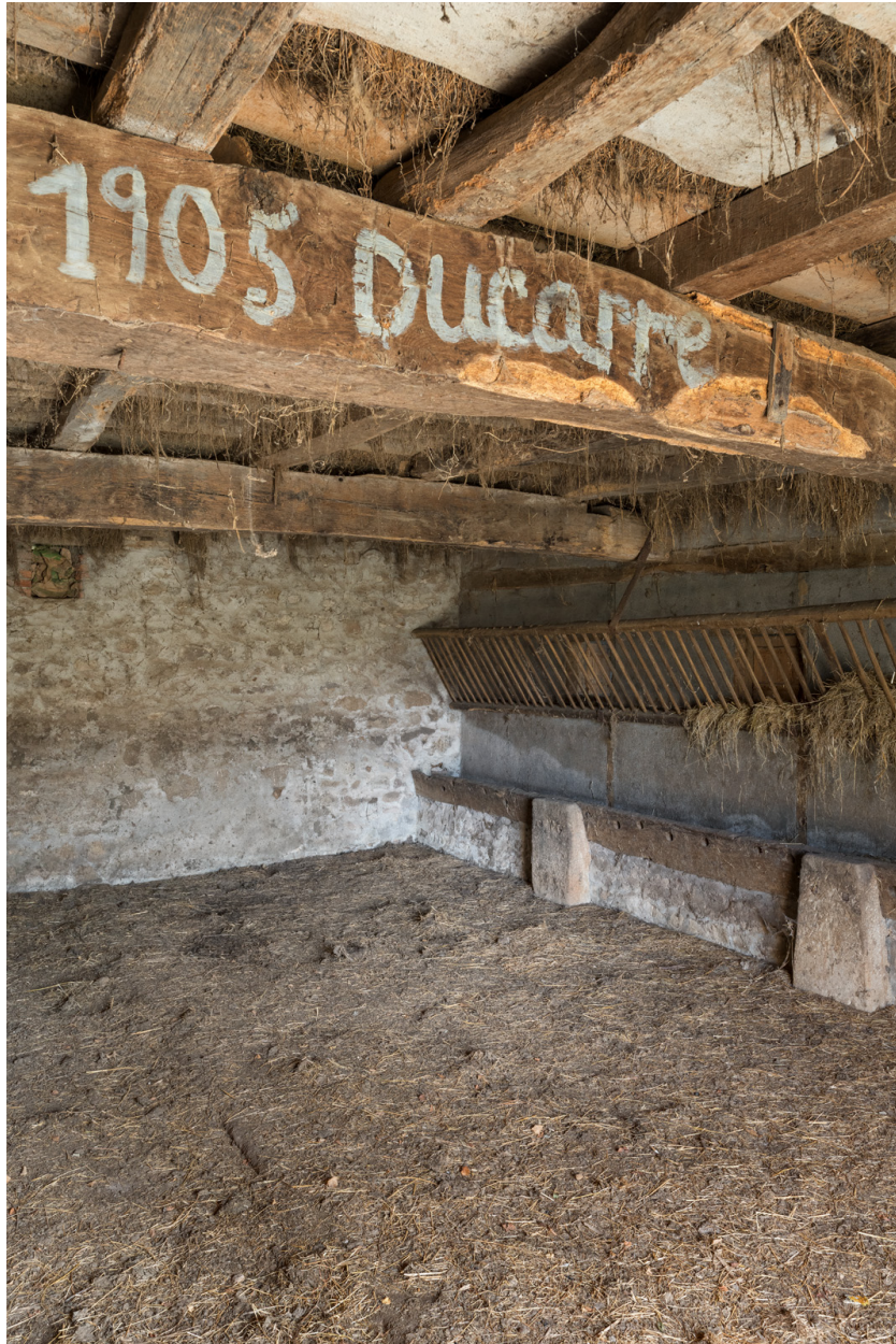
Vue intérieure de l'étable à vache. inscription et date sur la charpente.
