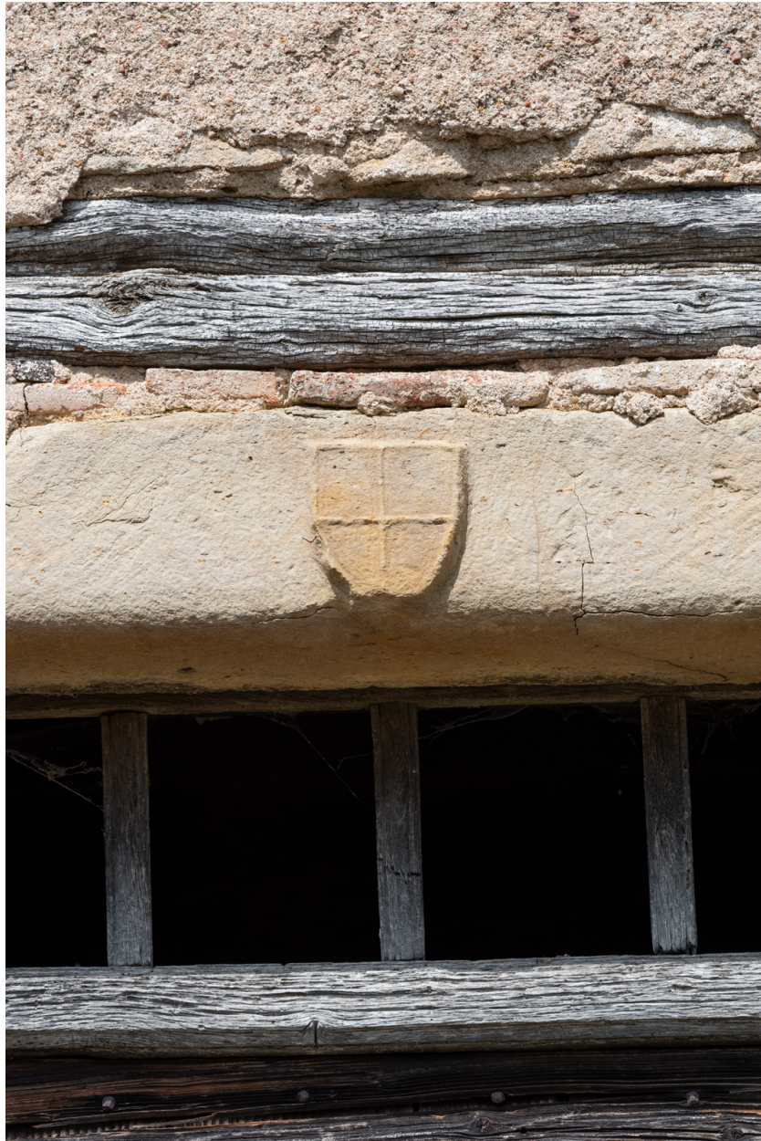
Détail du blason sur le linteau de la porte d'entrée.
