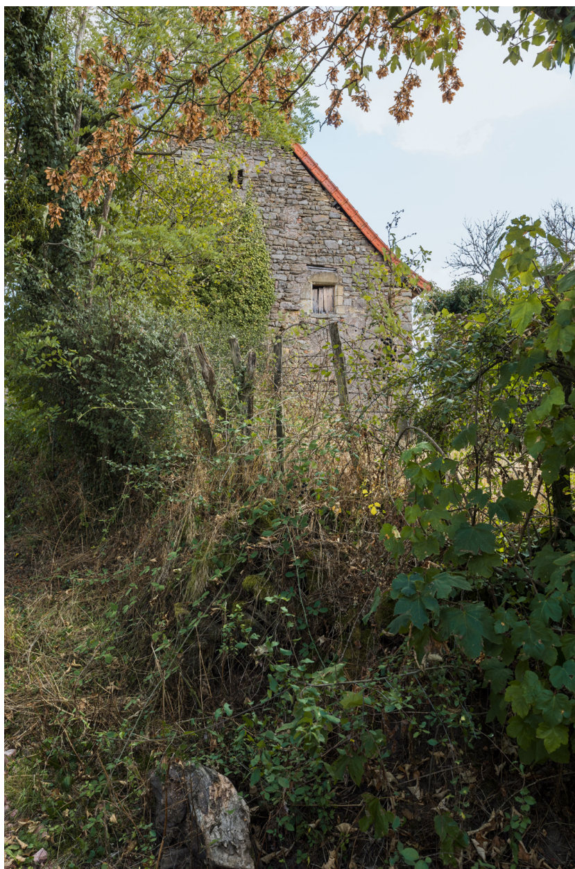
Pignon ouest de la partie agricole.
