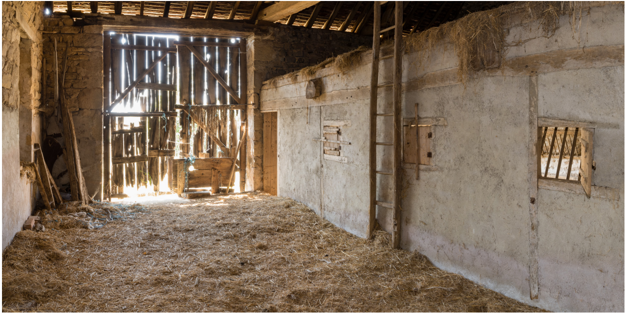
Vue intérieure du fenil.
