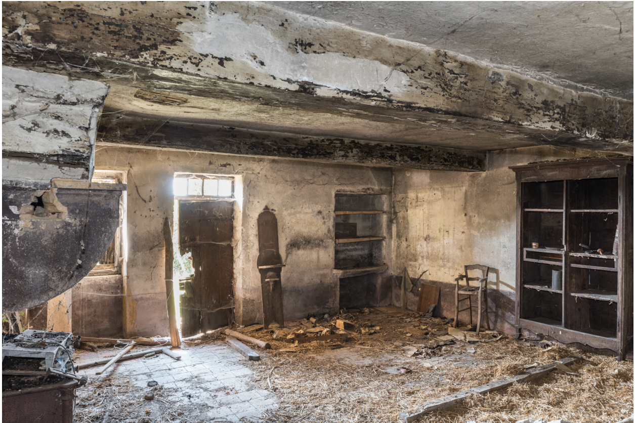
Vue intérieure de la pièce unique en rez-de-chaussée.
