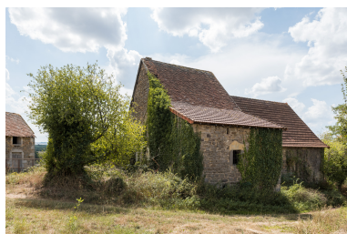
Vue de trois-quart nord-est des façades postérieures. Phot. Pierre-Marie Barbe-Richaud IVR26_20187100387NUC4A
