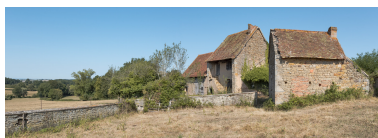
Vue d'ensemble depuis le sud-est des façades antérieures de la maison. Phot. Pierre-Marie Barbe-Richaud IVR26_20187100385NUC4AQ
