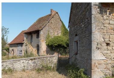
Vue rapprochée depuis l'angle sud de la dépendance. Phot. Pierre-Marie Barbe-Richaud IVR26_20187100388NUC4A
