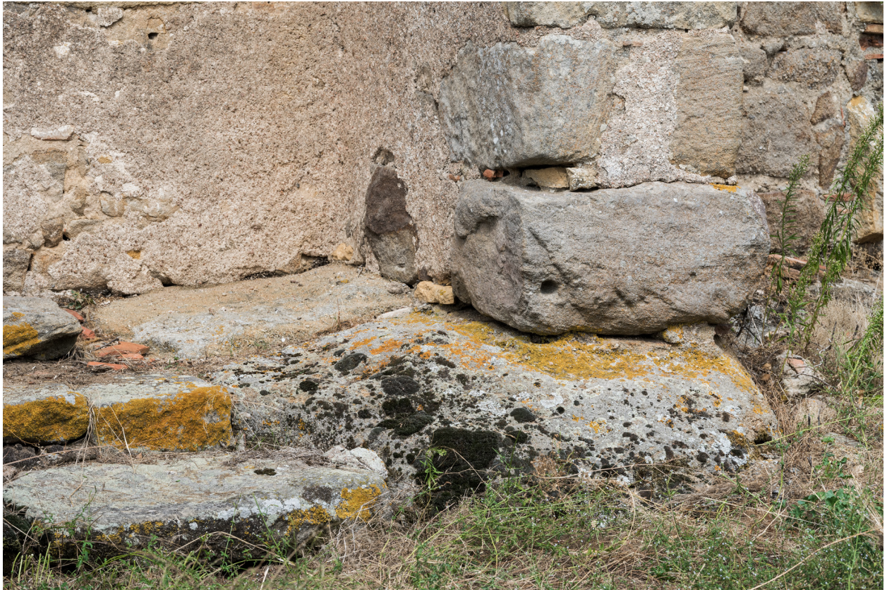
détail des marches et des affleurements de roche devant la maison.
