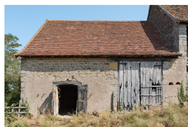
Vue de face des parties agricoles. Phot. Pierre-Marie Barbe-Richaud IVR26_20187100401NUC4A
