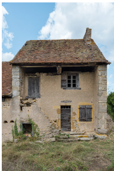
Vue de face de la façade antérieure de l'habitation. Phot. Pierre-Marie Barbe-Richaud IVR26_20187100390NUC4A
