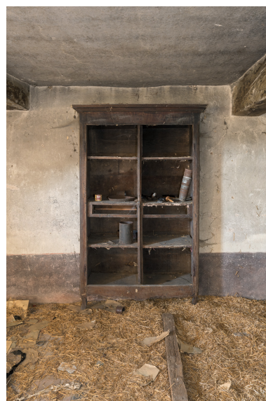
Vue de face d'un placard dans la pièce du rez-de-chaussée. Phot. Pierre-Marie Barbe-Richaud IVR26_20187100398NUC4A
