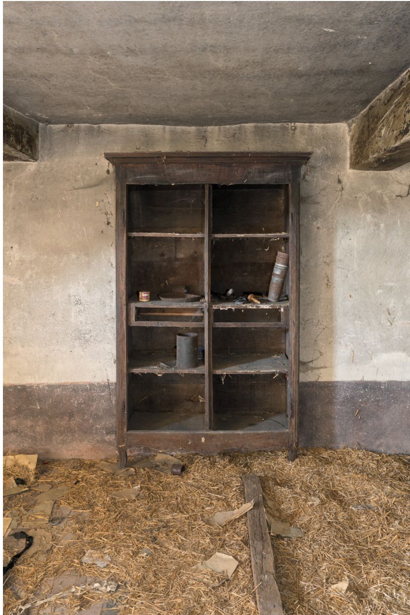
Vue de face d'un placard dans la pièce du rez-de-chaussée.
