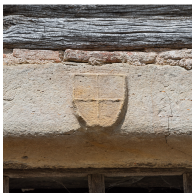
Vue rapprochée du blason sur le linteau de la porte d'entrée. Phot. Pierre-Marie Barbe-Richaud IVR26_20187100393NUC2A
