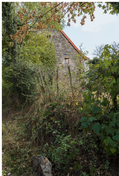
Pignon ouest de la partie agricole. Phot. Pierre-Marie Barbe-Richaud IVR26_20187100402NUC4A
