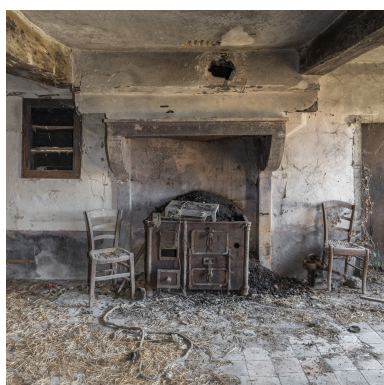
Vue de face de la cheminée. Pièce unique du rez-de-chaussée. Phot. Pierre-Marie Barbe-Richaud IVR26_20187100399NUC2A
