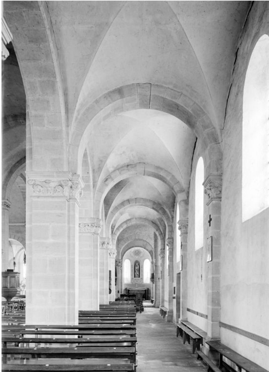
Bas-côté droit : vue d'ensemble depuis les fonts baptismaux.
