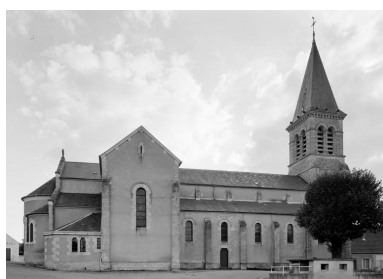
Élévation latérale gauche. Phot. Jean-Luc Duthu IVR26_19775800615V
