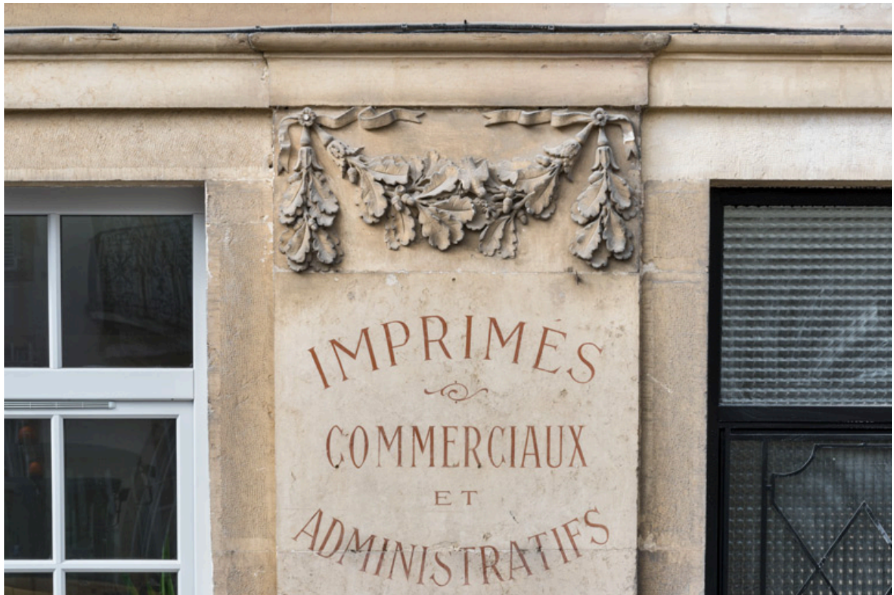
Façade antérieure, 3e pilastre (en partant de la gauche) : guirlande sculptée et inscriptions.
