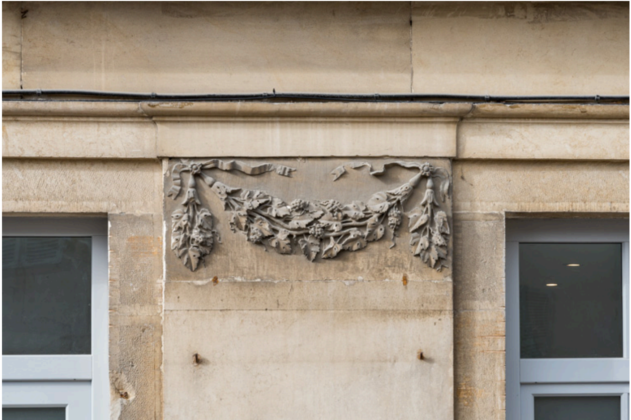
Façade antérieure, 5e pilastre (en partant de la gauche) : guirlande sculptée.
