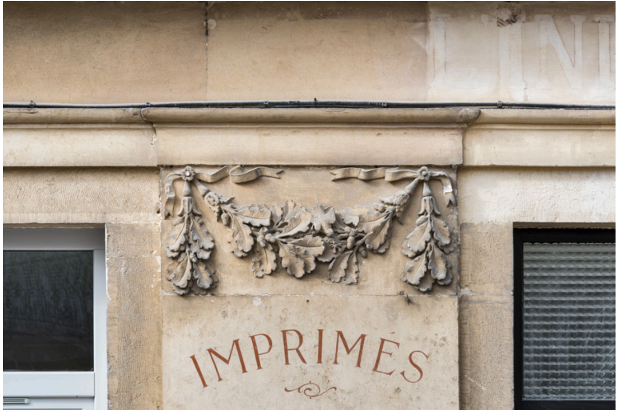
Façade antérieure, 3e pilastre (en partant de la gauche) : guirlande sculptée.
