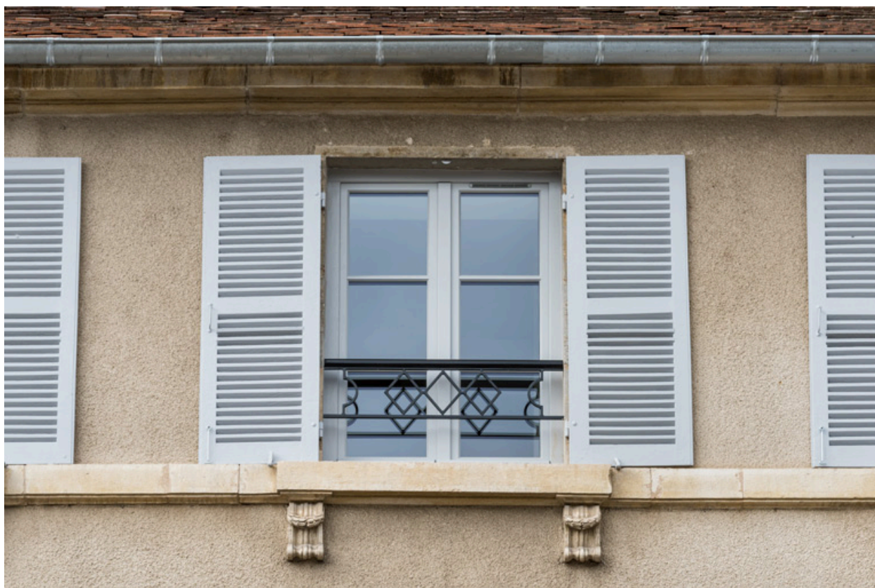
Façade antérieure : fenêtre du 2e étage.
