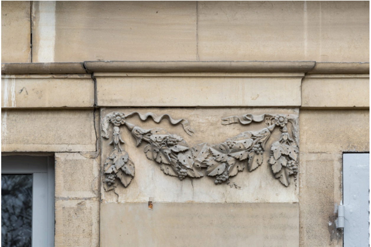
Façade latérale gauche, 3e pilastre (en partant de la gauche) : guirlande sculptée.
