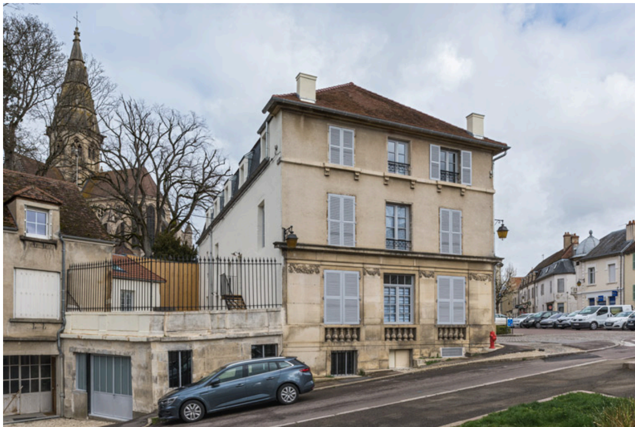
Façade latérale gauche.
