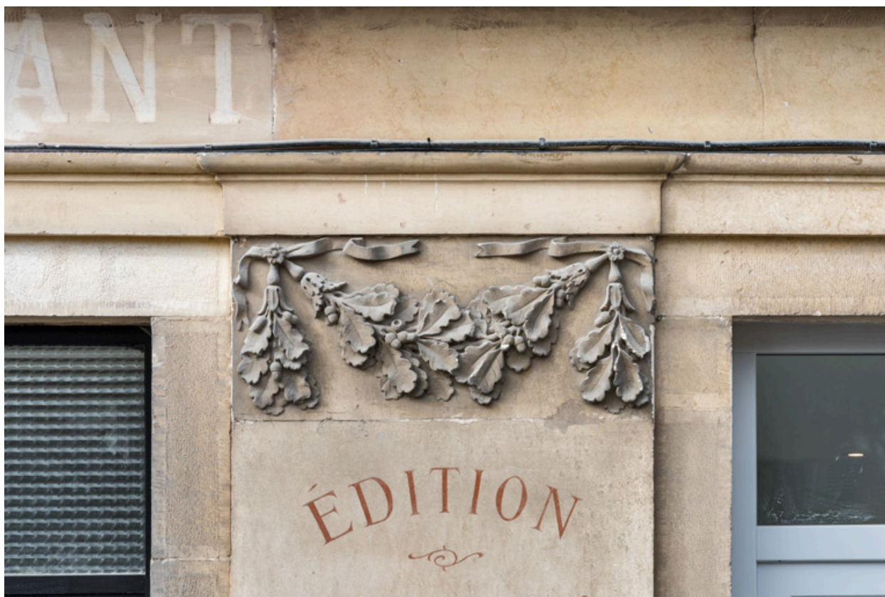
Façade antérieure, 4e pilastre (en partant de la gauche) : guirlande sculptée.
