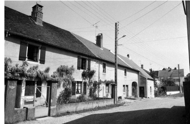
Vue de trois quarts gauche. Phot. Bernard Lardière IVR43_19817000324Z
