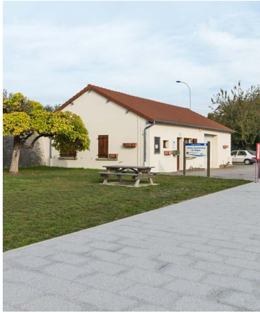
Vue d'ensemble de la maison de garde.
