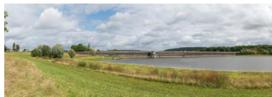
Vue d'ensemble. Phot. Pierre-Marie Barbe-Richaud IVR26_20172100580NUC2AQ
