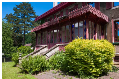
Véranda sur la façade ouest. Phot. Jérôme Mongreville IVR43_20132500675NUC4A
