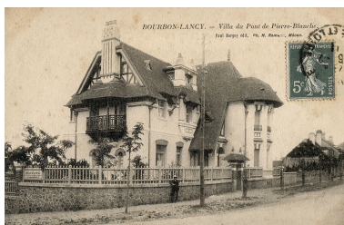
Vue ancienne. Autr. auteur inconnu IVR26_20207100071NUC4A
