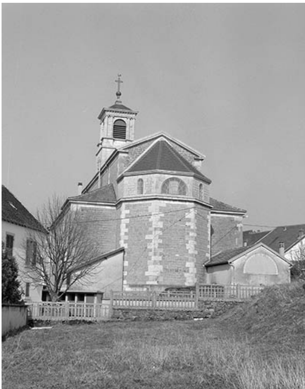
Extérieur : abside vue de trois quarts.
