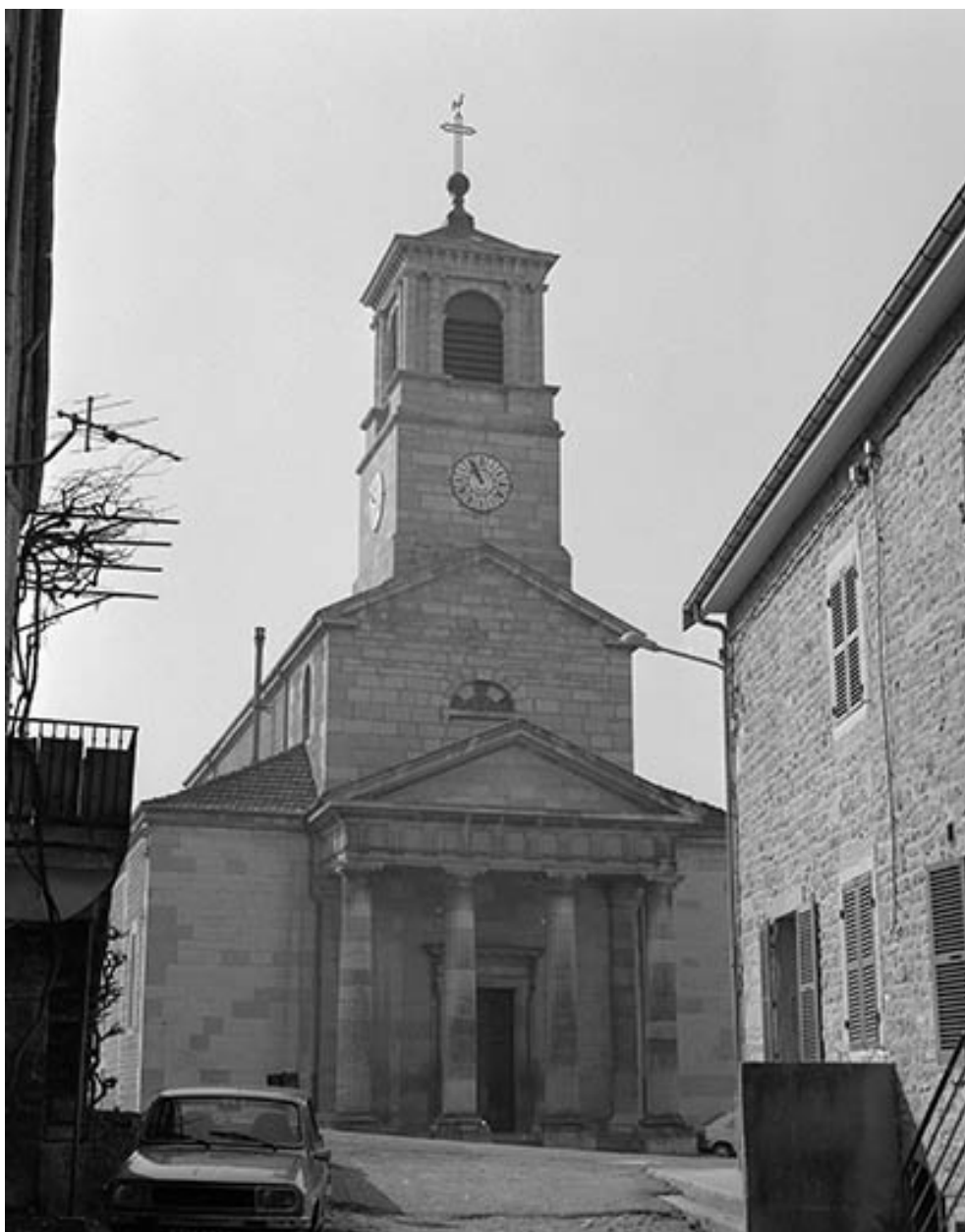
Extérieur : façade antérieure.
