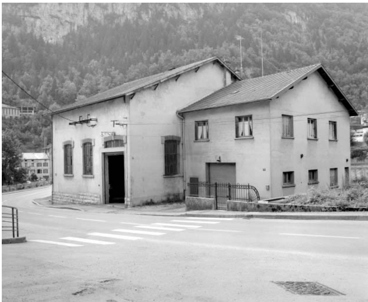
Façade antérieure vue de trois quarts droite.
