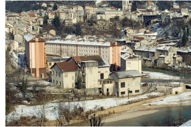
Vue d'ensemble rapprochée depuis l'ouest. Phot. Laurent Poupard IVR43_19923901322ZA
