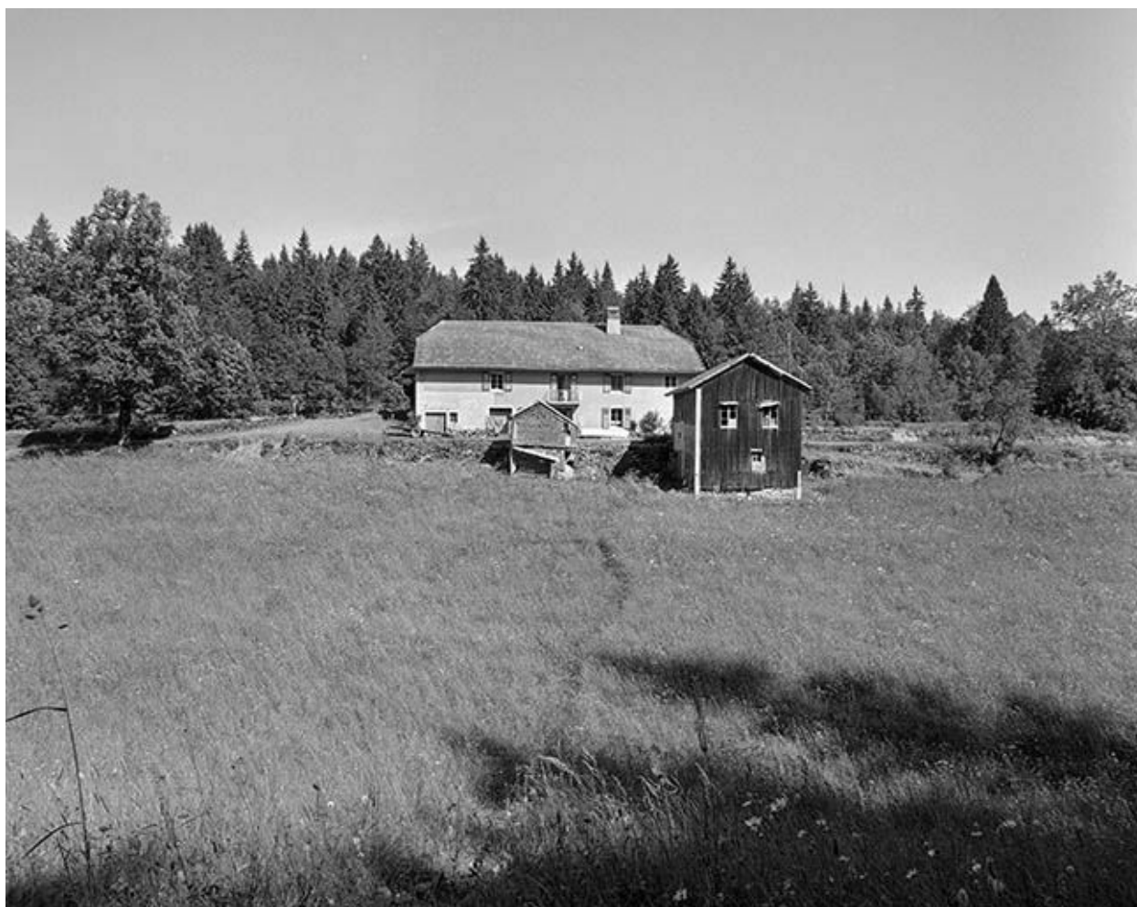
Façade antérieure, vue éloignée.
