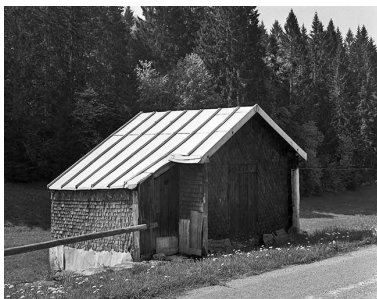
Resserre, appelée " grenier fort ". Phot. Jérôme Mongreville IVR43_20013900556X
