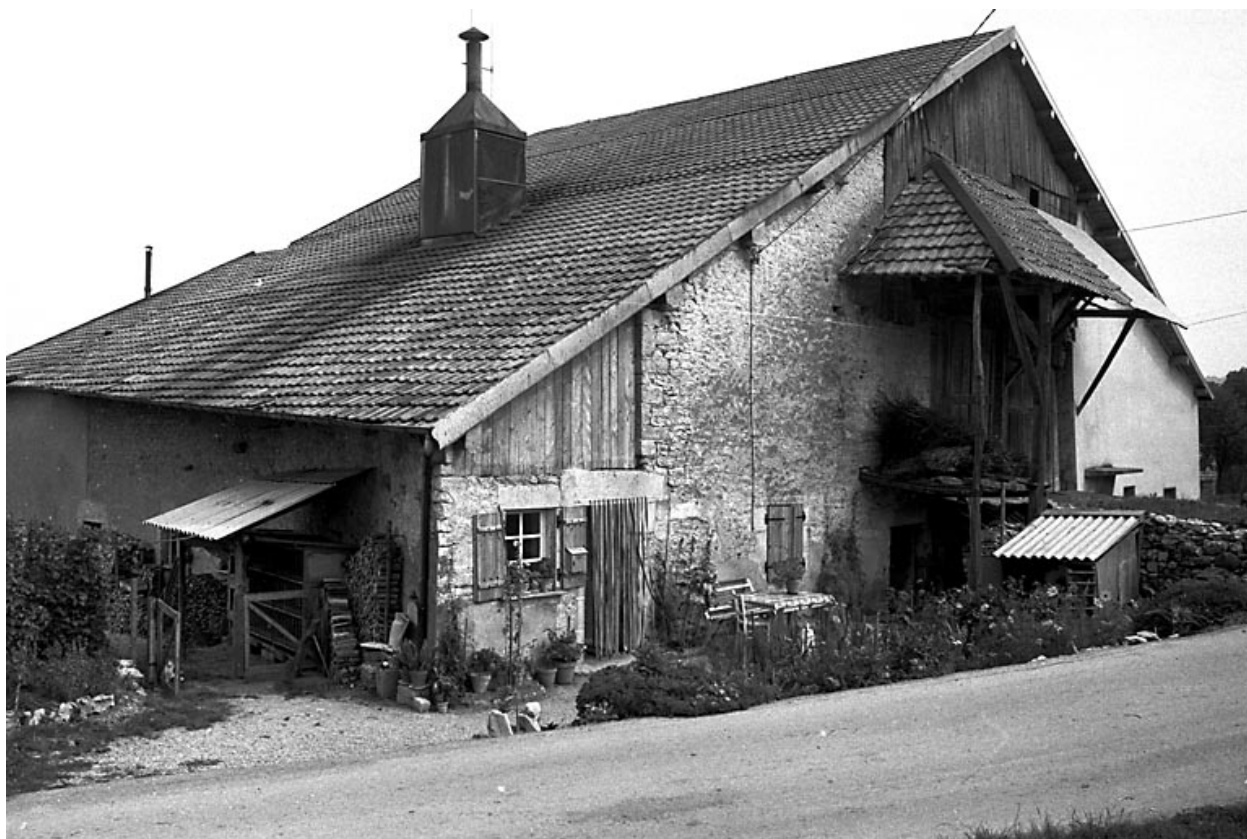
Ferme située 3 rue du Chalet.
