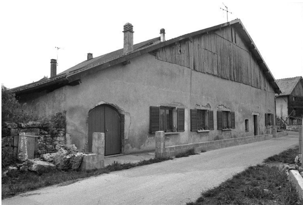
Ferme située 10 rue du Chalet : façade antérieure.
