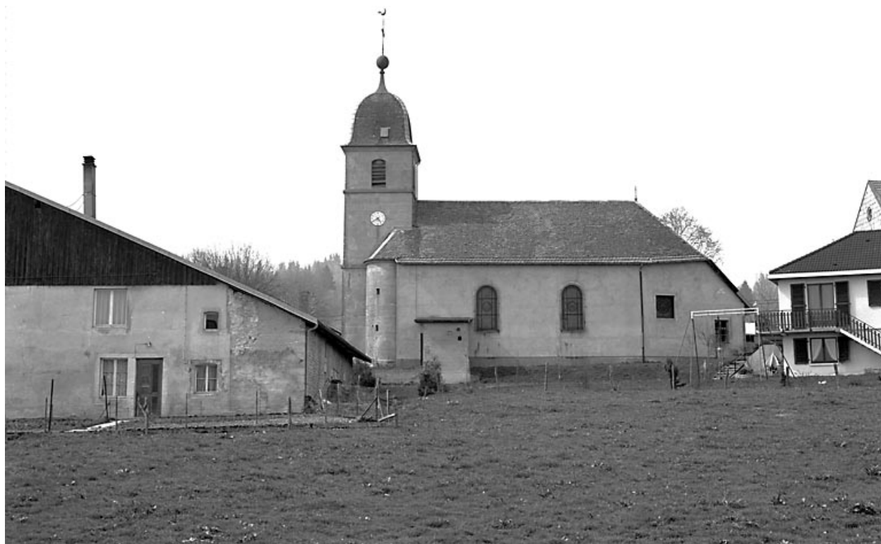
Façade latérale sud.
