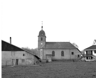
Façade latérale sud. Phot. Yves Sancey IVR43_19812500110X
