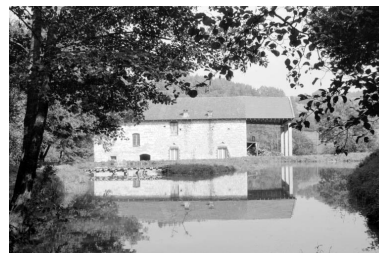
Façade postérieure. Phot. Laurent Poupard IVR43_19923901207Z
