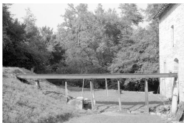
Conduite d'amenée de la roue. Phot. Laurent Poupard IVR43_19923901209Z
