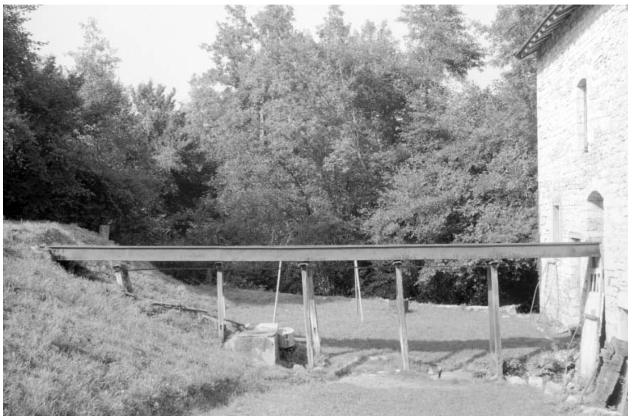
Conduite d'amenée de la roue.
