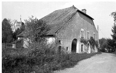
Vue d'ensemble. Phot. Bernard Lardière IVR43_19797000155Z
