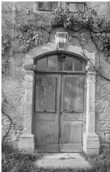
Détail : porte d'entrée de l'habitation. Phot. Bernard Lardière IVR43_19797000156Z
