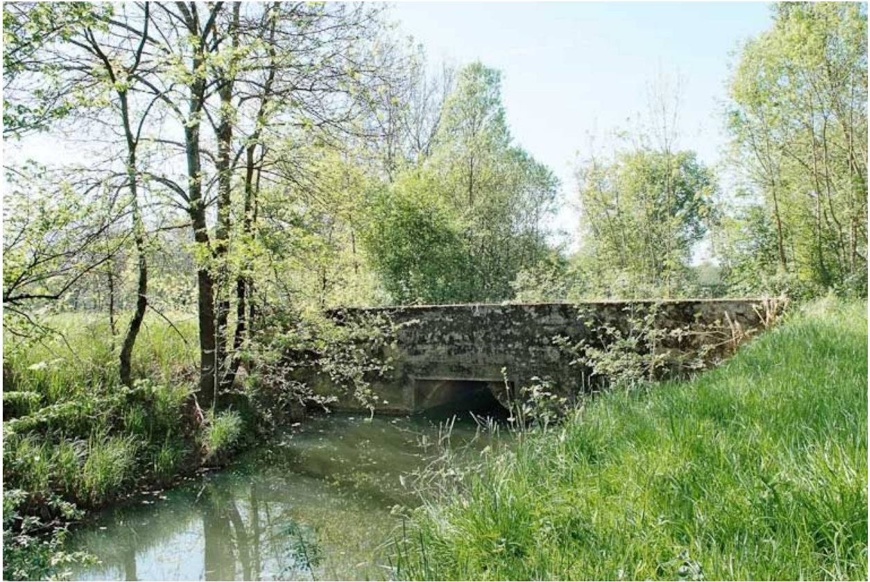
Pont ancien modifié.
