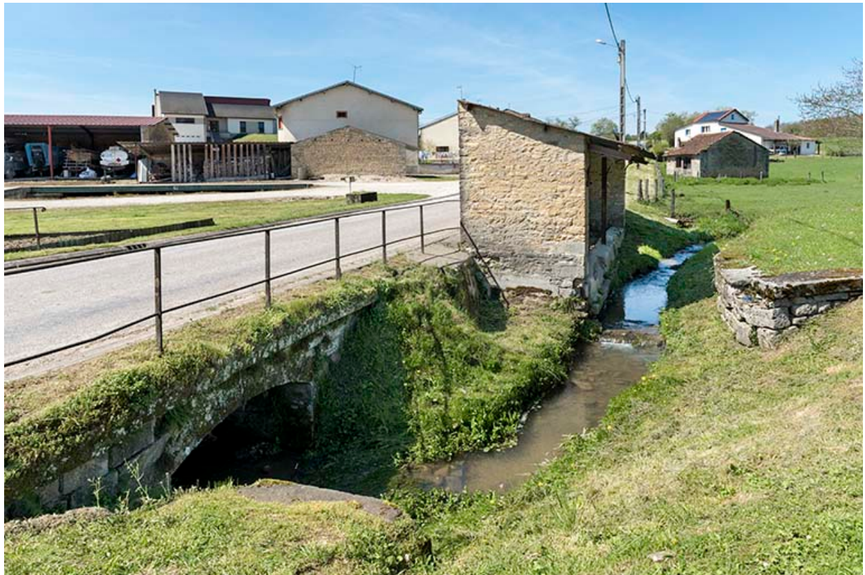
Vue générale du lavoir, Grande rue.
