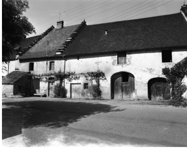
Façade antérieure en 1981. Phot. Yves Sancey IVR43_19813900206X
