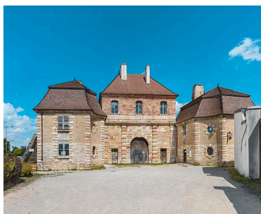
Vue générale. Phot. Thierry Kuntz IVR26_20232100516NUC4A
