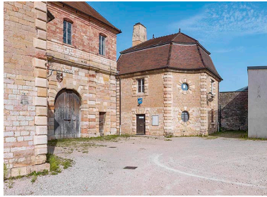
L'entrée cochère et un des pavillons. Phot. Thierry Kuntz IVR26_20232100418NUC4A
