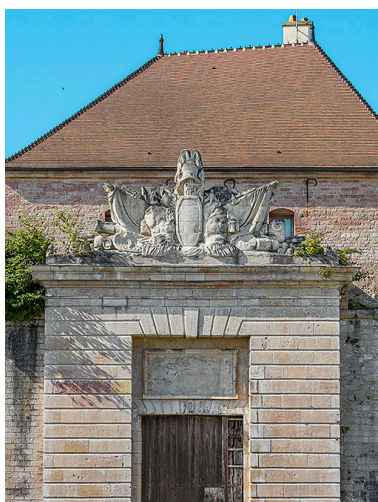
La porte Royale. Phot. Thierry Kuntz IVR26_20232100214NUC4A
