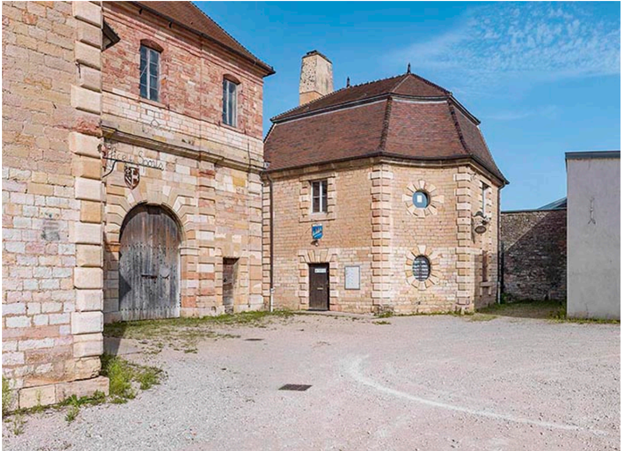
L'entrée cochère et un des pavillons.
