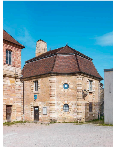
Détail du pavillon est. Phot. Thierry Kuntz IVR26_20232100417NUC4A
