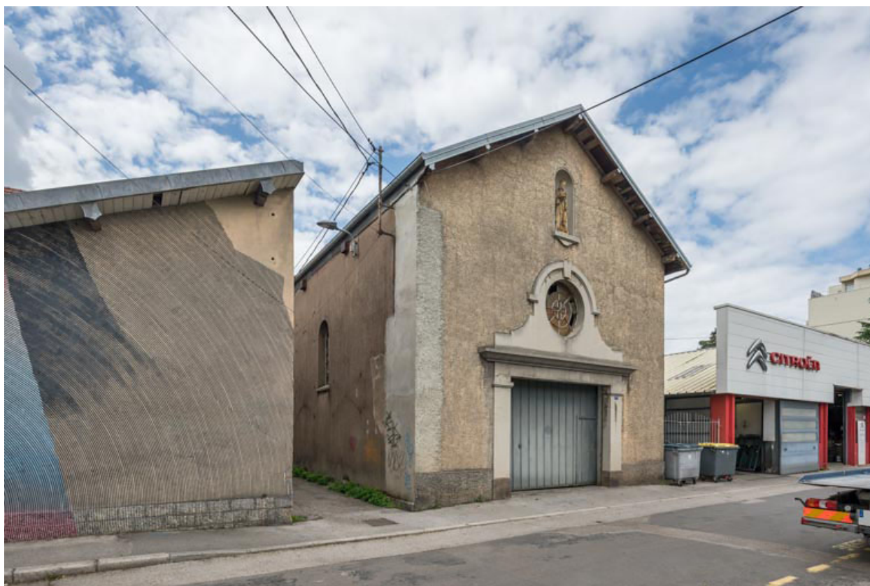
Façade antérieure. Vue d'ensemble.
