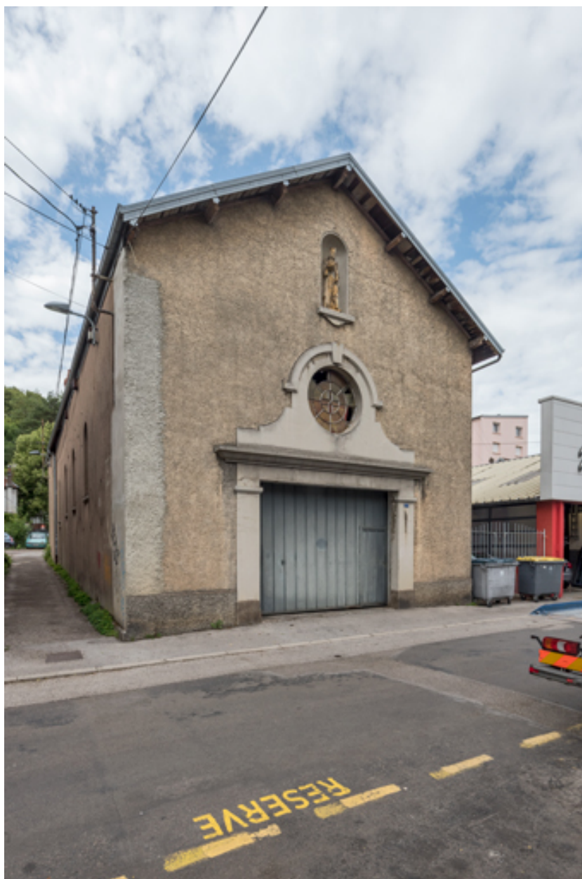
Façade antérieure de l'église. Vue de trois quarts.
