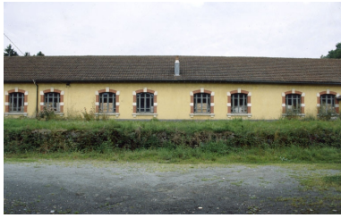
Façade sud de l'atelier de tissage.
