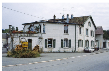
Vue d'ensemble depuis l'avenue de Schwabmünchen. Phot. Yves Sancey IVR43_19999000373ZA
