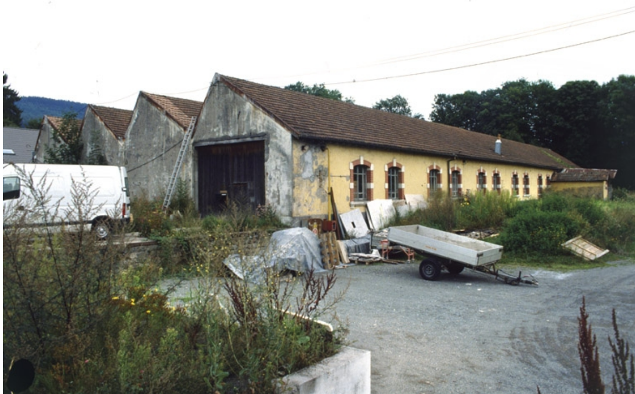
Atelier de fabrication (tissage) depuis le sud-ouest.
