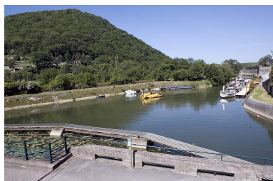
Bassin, depuis la route à l'est. Phot. Yves Sancey IVR43_20062500216NUCA
