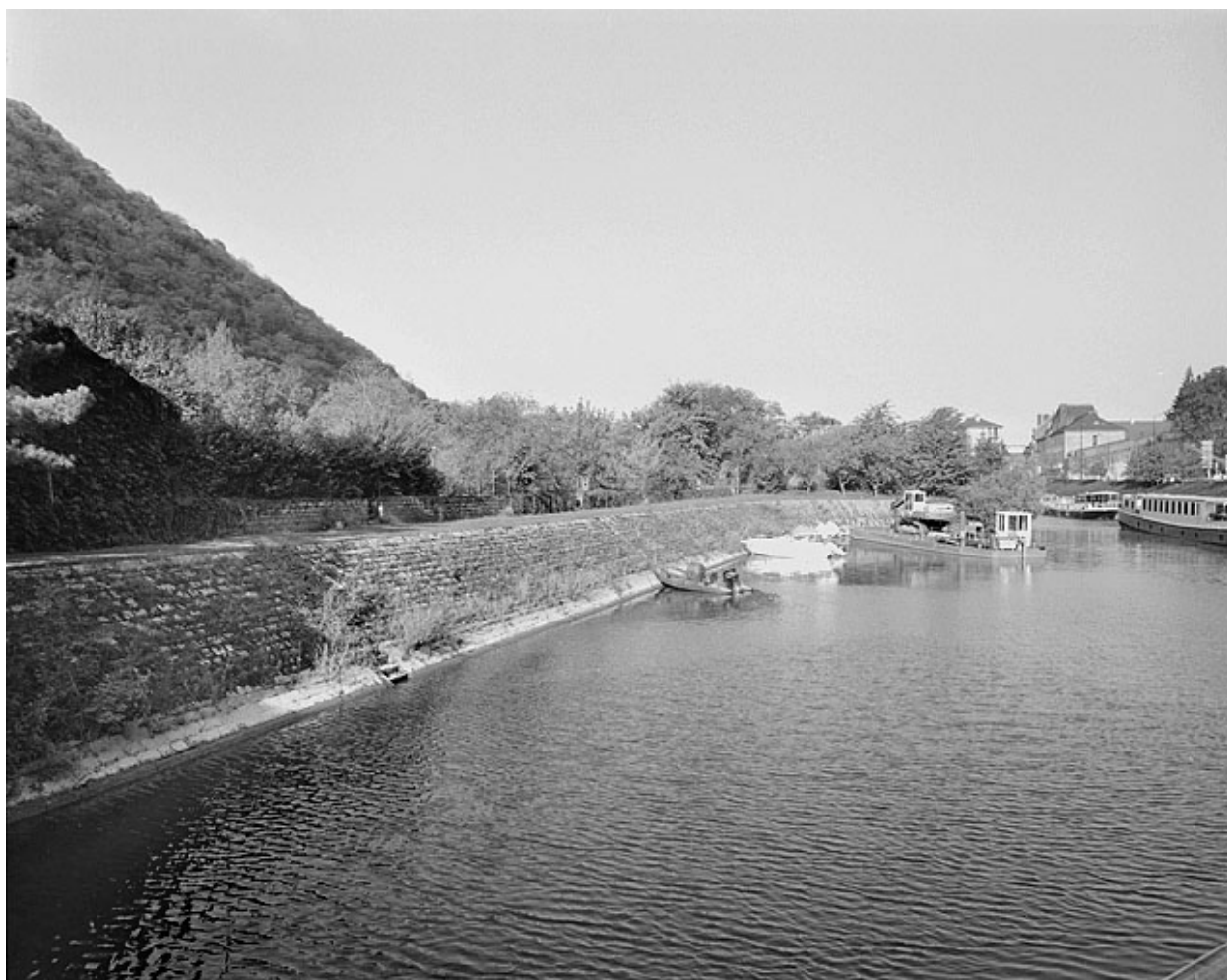
Perré sud (côté île).
