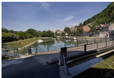
Vue d'ensemble depuis l'écluse n° 51. Phot. Yves Sancey IVR43_20062500226NUCA
