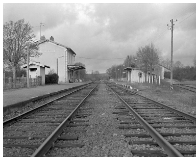
Vue d'ensemble prise depuis le passage à niveau Phot. Jean-Luc Duthu IVR26_19925800241X
