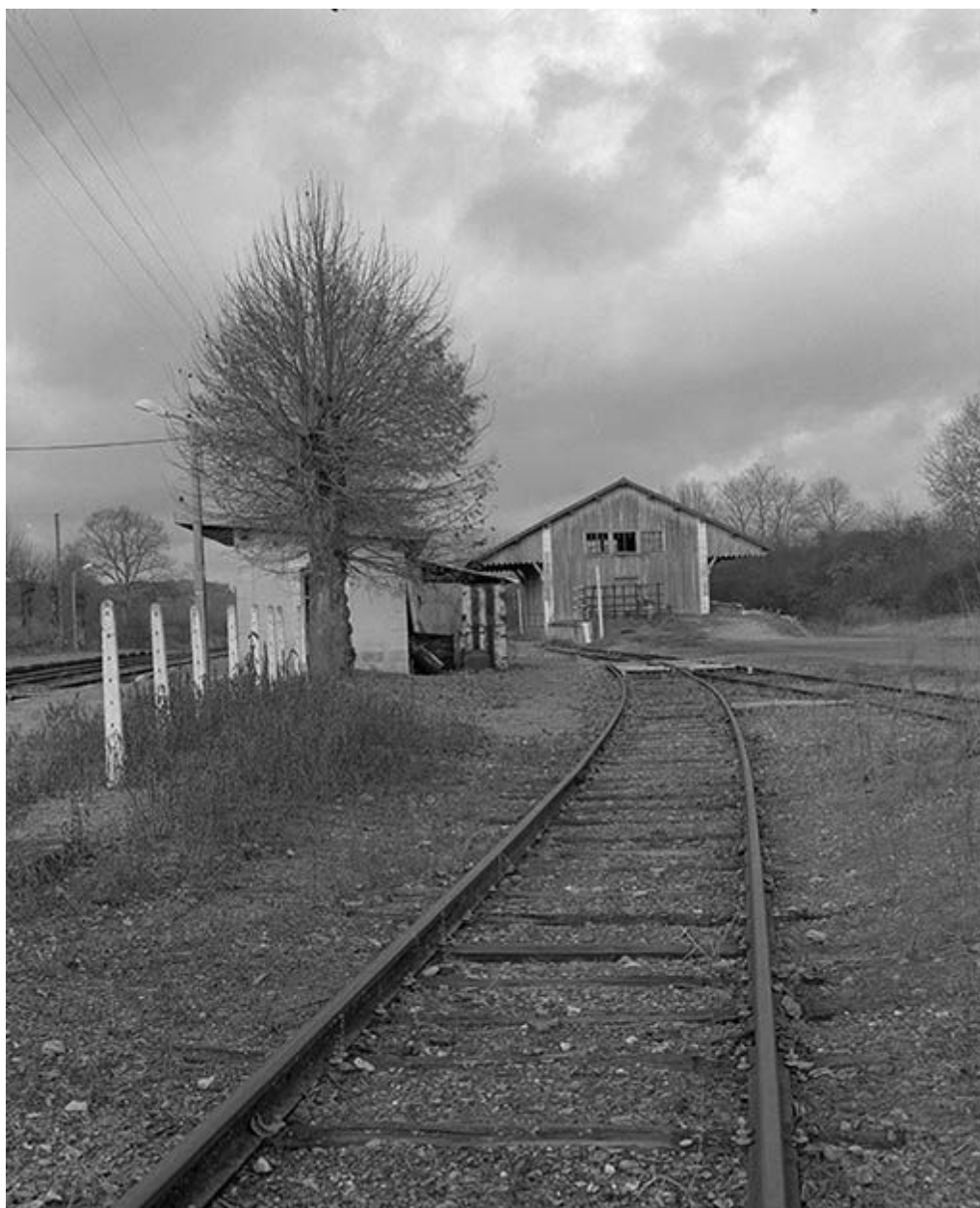
L'abri des voyageurs et le hangar
