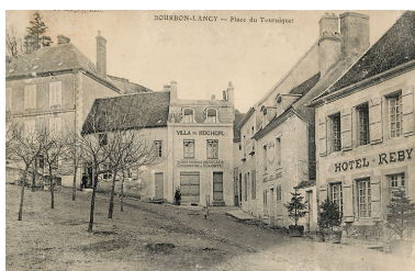
Façade de la maison sur la place du Tourniquet. Autr. auteur inconnu IVR26_20207100069NUC4A
