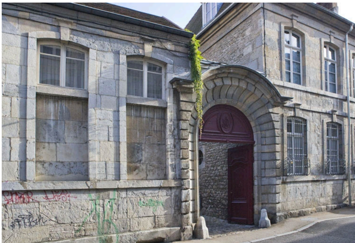
Détail du portail d'entrée, de trois quarts gauche.
