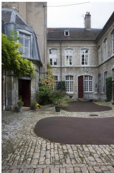
Vue d'ensemble des façades sur cour de l'hôtel. Phot. Yves Sancey IVR43_20092501472NUC2A
