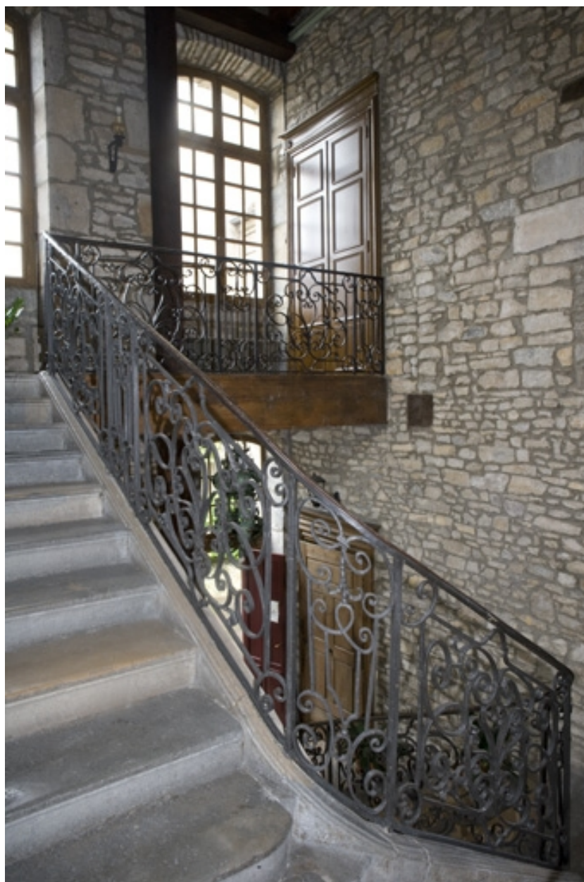
Intérieur : détail de la rampe en fer forgé de l'escalier d'honneur.
