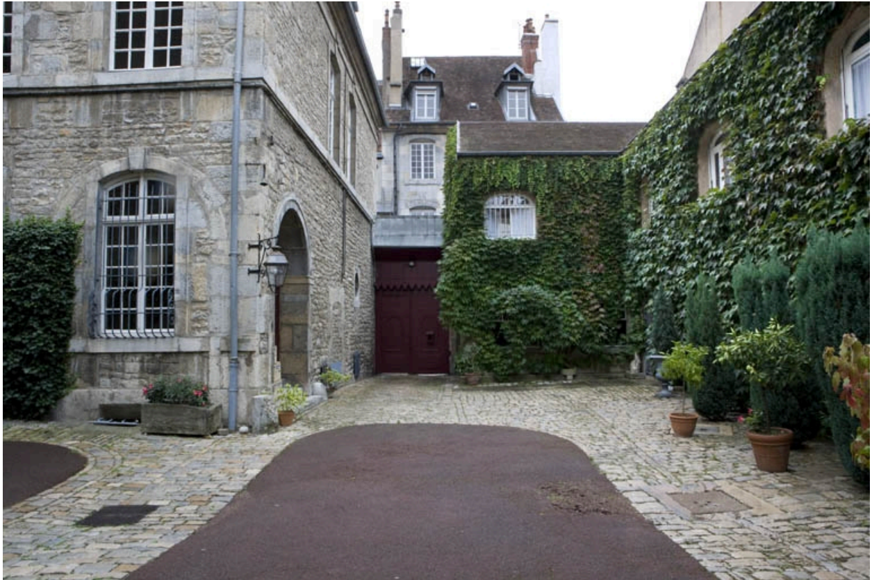
Vue d'ensemble de la cour depuis le bâtiment des communs.
