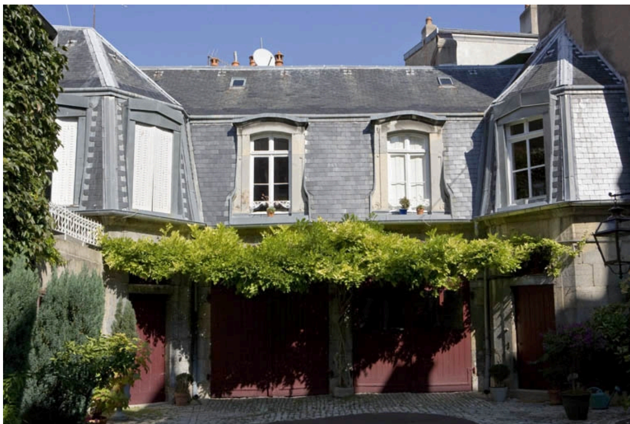
Vue d'ensemble du bâtiment des communs situé en fond de cour.
