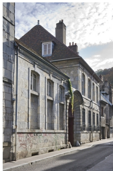
Vue d'ensemble depuis la rue, de trois quarts gauche. Phot. Yves Sancey IVR43_20092501464NUC2A
