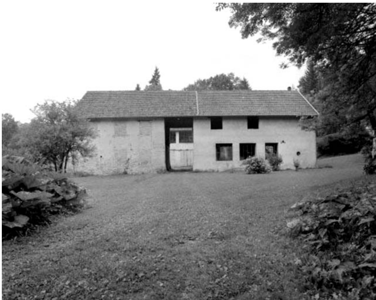
Façade postérieure de l'atelier de fabrication sud.
