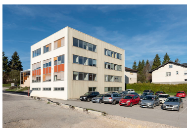
Façades est et nord. Phot. Sonia Dourlot IVR43_20182501000NUC4A
