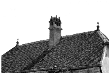
Détail du toit recouvert de tuiles plates Phot. Bernard Lardière IVR43_19817000548Z
