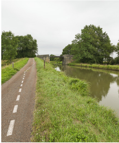
Vue d'ensemble du pont et du site. Phot. Pierre-Marie Barbe-Richaud IVR26_20175800176NUC2A
