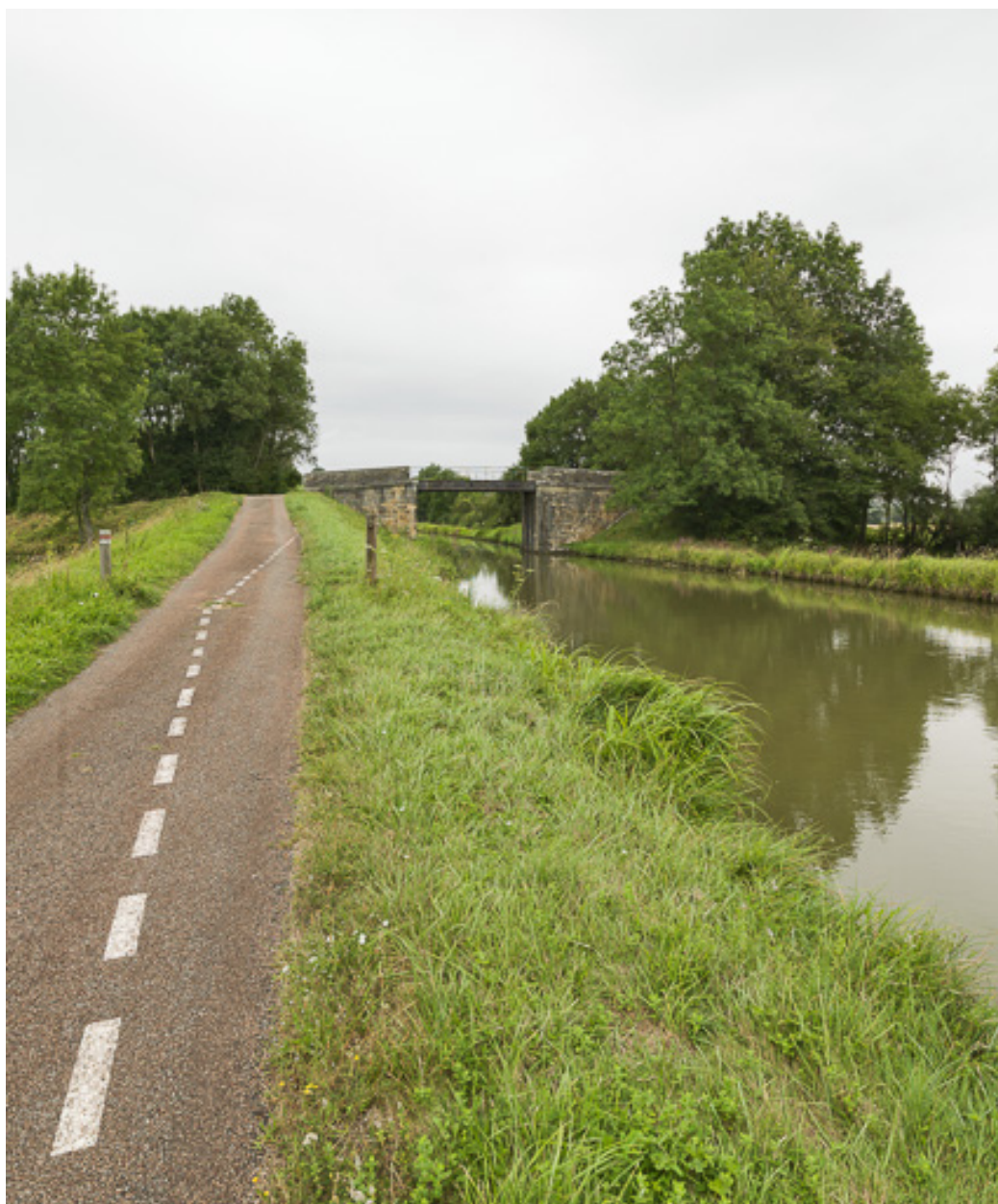
Vue d'ensemble du pont et du site.
