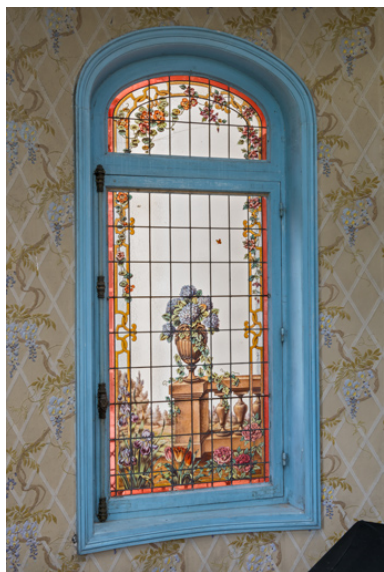
Baie de la salle de billard. Phot. Pierre-Marie Barbe-Richaud IVR26_20245800097NUC4A
